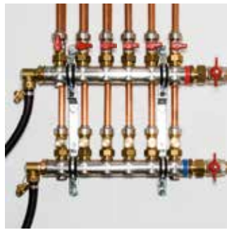
Lämpöpatteri- ja pintalämmitysjärjestelmien huuhtelu
