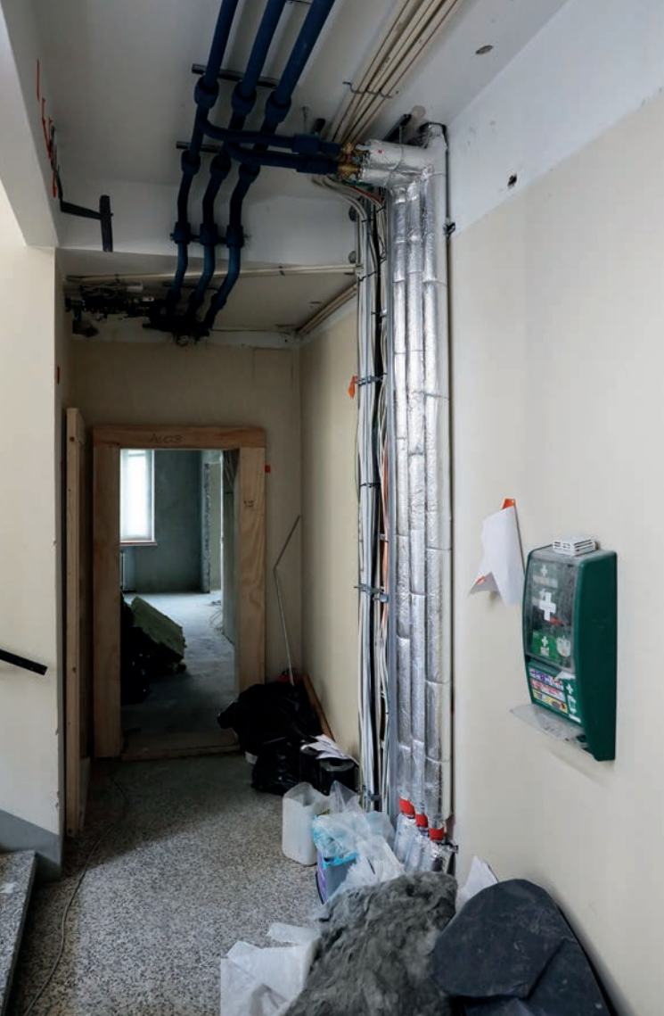
Uudet vesijohtonousut porrashuoneessa ennen kotelointoja.
