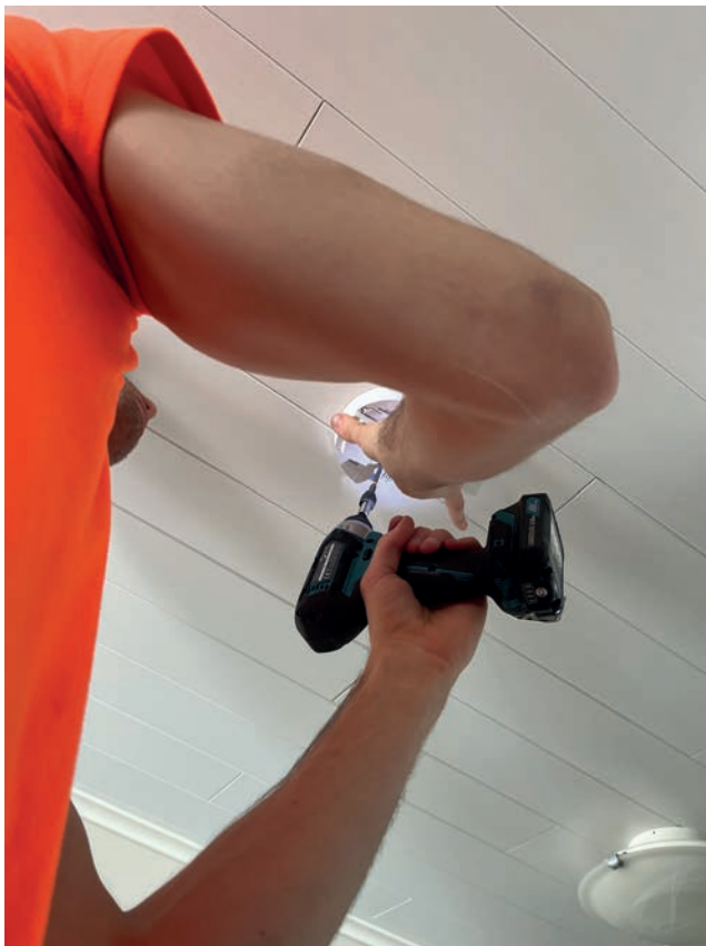
Palovaroittimen asennus.
