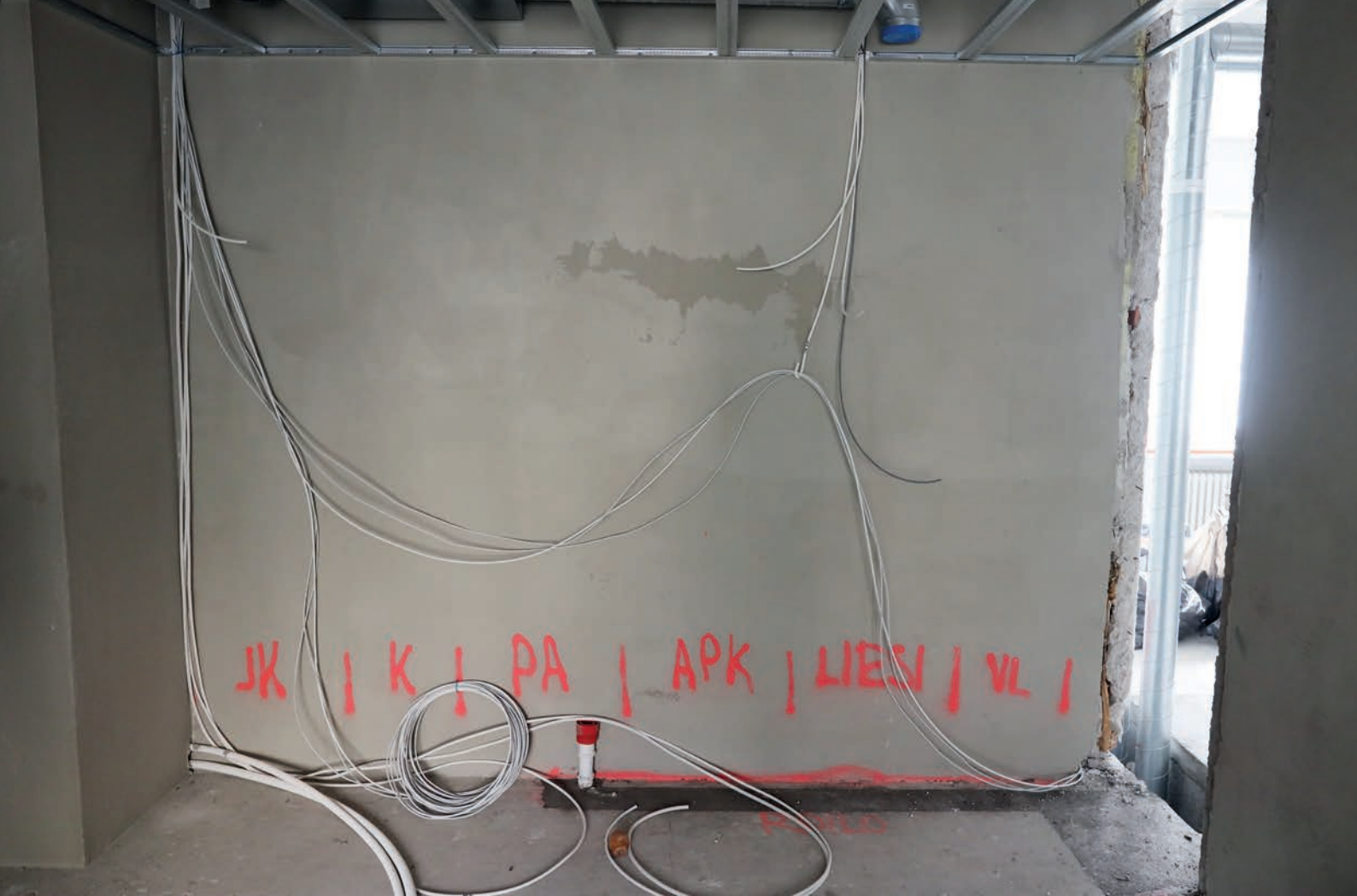
Täysin purettu keittiö ennen uudelleenrakennusta.
