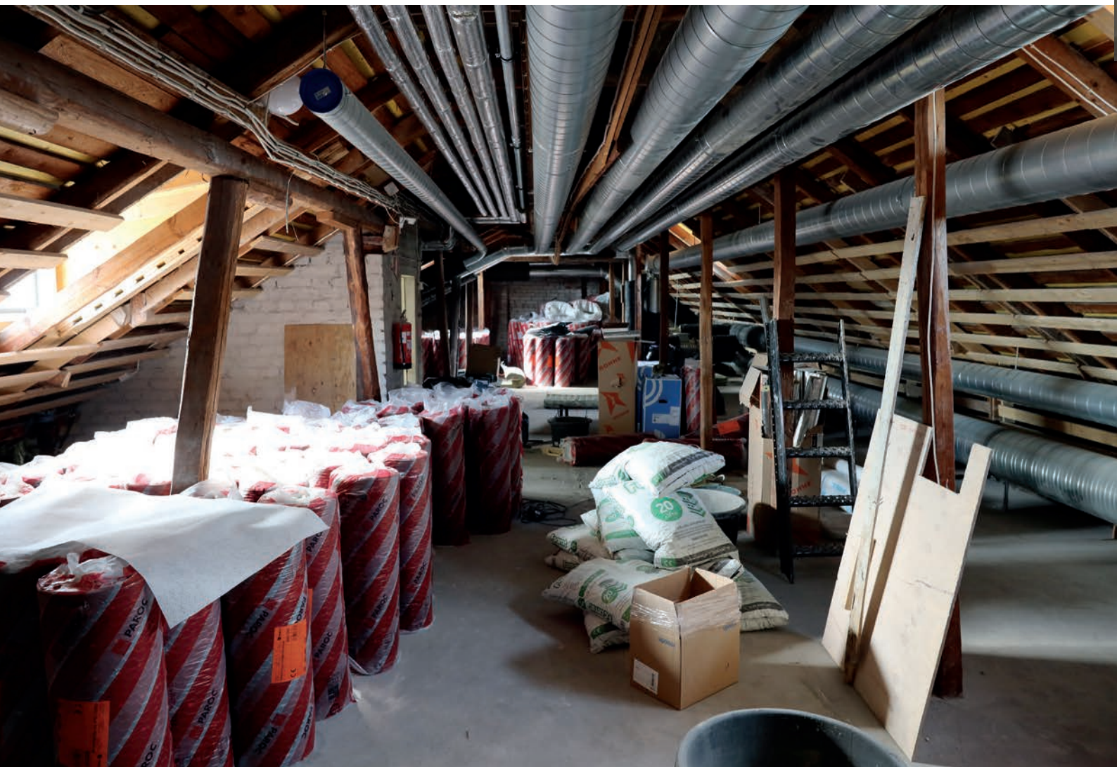
Laajat ilmanvaihtotyöt vaiheessa ullakolla.
