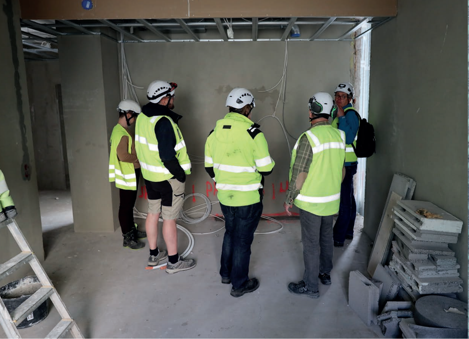
Työmaakatselmus menossa. Kohteessa on tekeillä laajempi putkiremontti, jossa koko huoneiston pinnat uusitaan.
