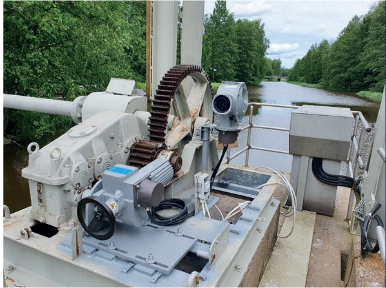
AUMA SEVEN ohjaamassa patoluukkuja Hiidenvedellä.
