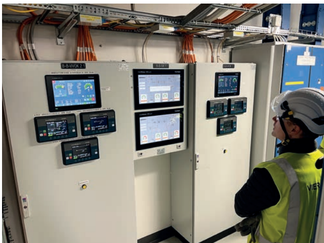
Varavoimajärjestelmän ohjauskeskukset.
