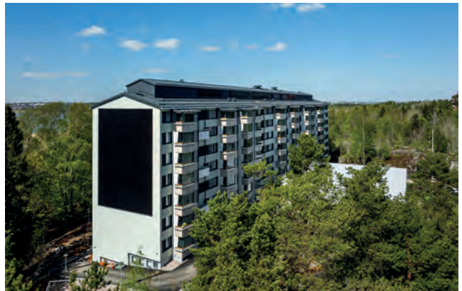
Helsingin kaupungin asunnot Oy:n omistamassa Mäenlaskijantie 4:ssä on asennettu aurinkopaneelijärjestelmä, jossa aurinkoenergia yhdistetään julkisivuun ulkonäöstä tinkimättä. Kohteen pääurakoitsijana toiminut PEAB Oy, suunnittelu Arkkitehtitoimisto Hyvärinen & Co Oy, rakennesuunnittelu Sitowise Oy ja sähkösuunnittelu Hepacon Oy.
