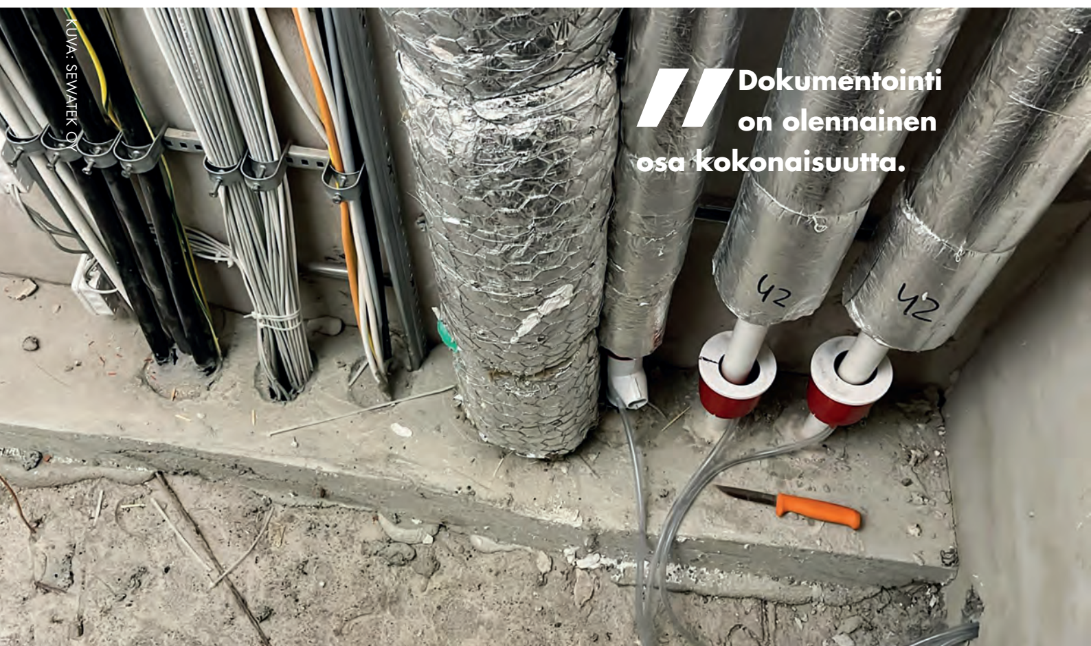
Kuvassa asennettu esivalmistettuja palokatkotuotteita.
