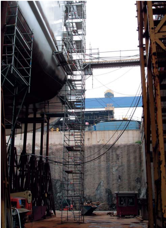
Teline-Ramin telineitä Turun telakalla
