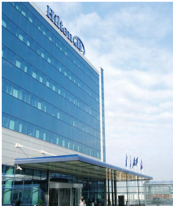
KUVA: HILTON HELSINKI-VANTAA AIRPORT
