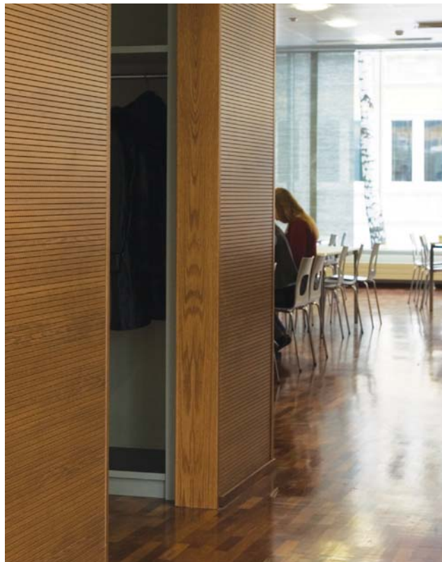
Topakustik yrityksen kanttiinin seinäpinnoissa.
