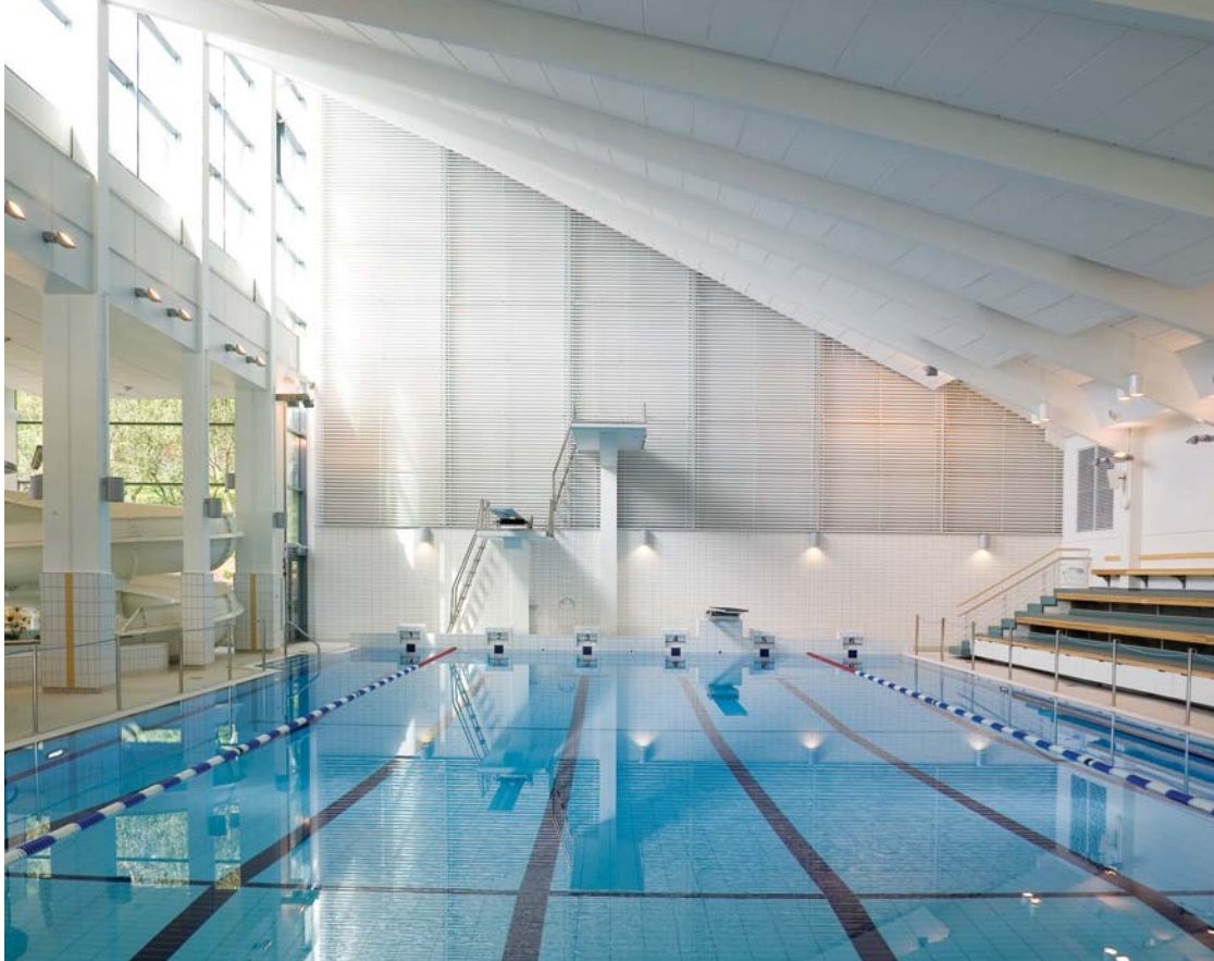
Vanhan osan akustiikka ratkaistiin asentamalla Wilng-reunaiset Ecophon Focus E -kentät betonipalkkien väliin. Lisähaastetta toi katon kiertyvä muoto.
