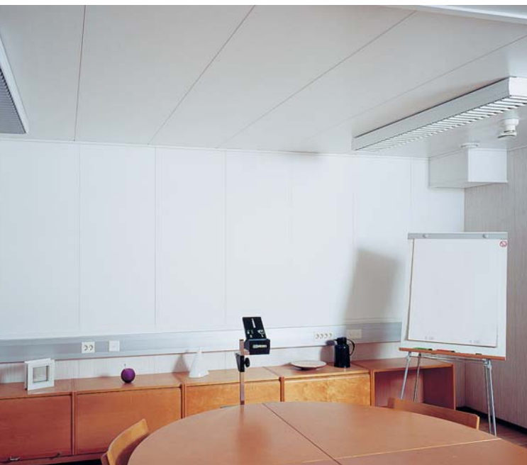
Neuvotteluhuoneen seinässä Halltex Villa 03 tekstiilipintainen sisäverhouslevy, joka toimii paitsi valkokankaana ja akustiikkalevyinä, myös tarvittaessa fläppien, piirustusten ja kaavioiden kiinnityspintana.
