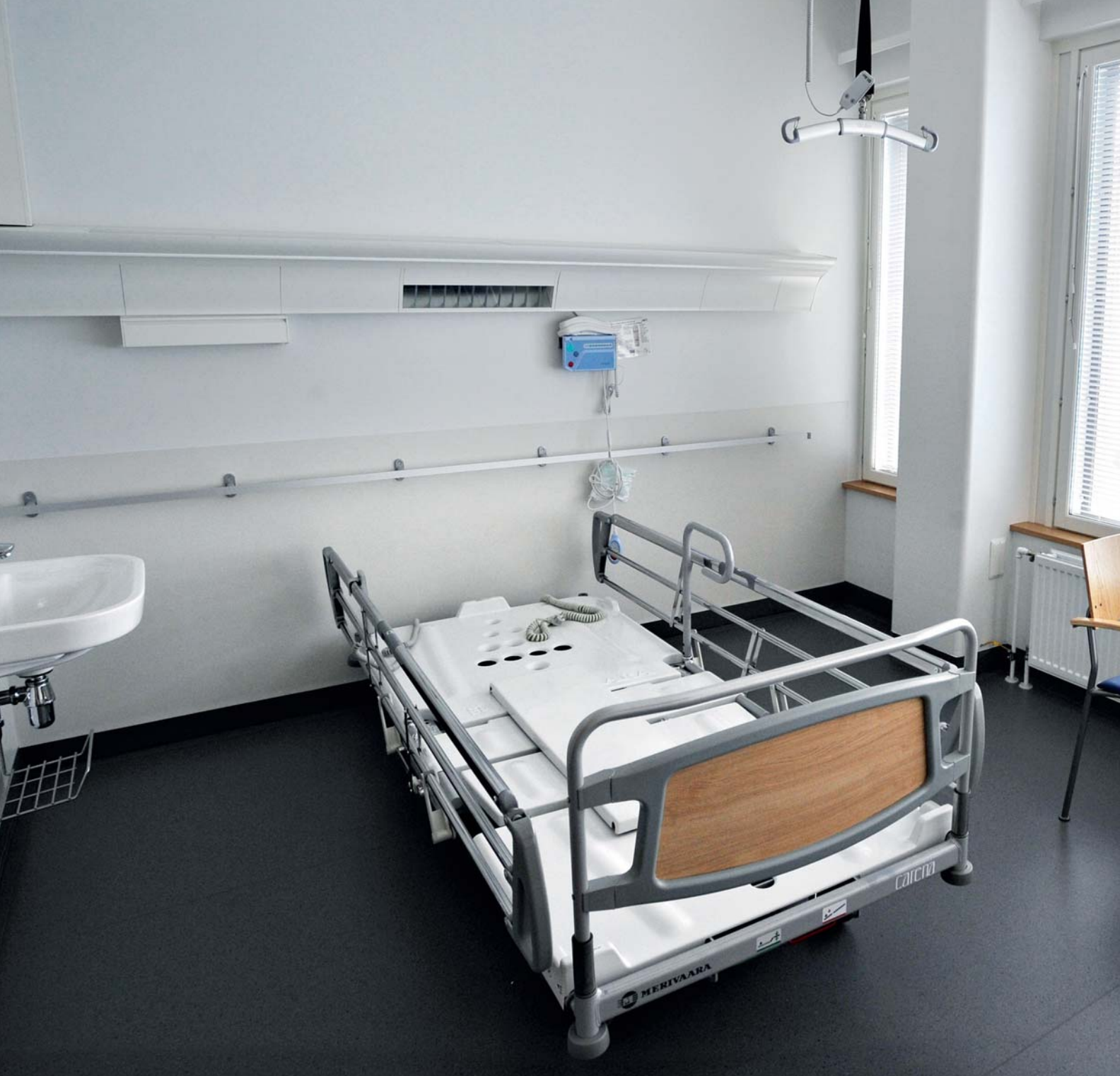
Kuvassa Fagerhultin ELG-sarjan potilaspaneeli, johon on integroitu huoneen yleisvalaistus, luku- ja tutkimusvalot. Pistorasiat ja kaasuliitännät on sijoitettu paneelin etupinnassa olevien luukkujen taakse.
