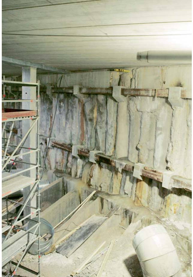
Musiikkitalo on eristetty pohjavedestä 500 metriä pitkällä patoseinällä.
