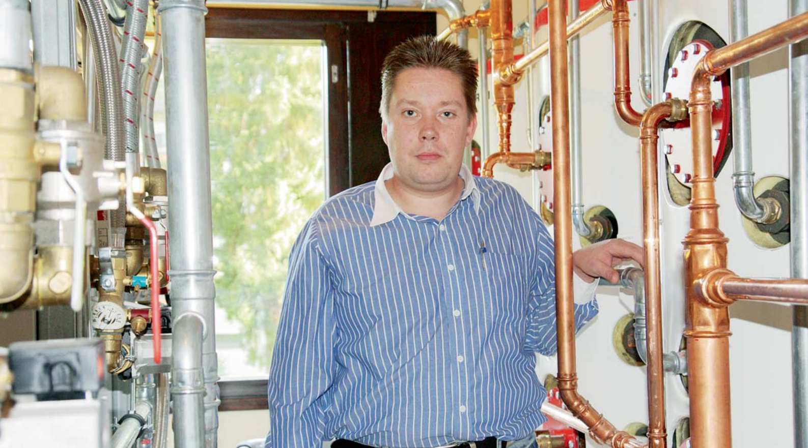
Green Heatin projektipäällikkö Mika Hytönen Taivalkunnantien kerrostalon lämpöhuoneessa.
