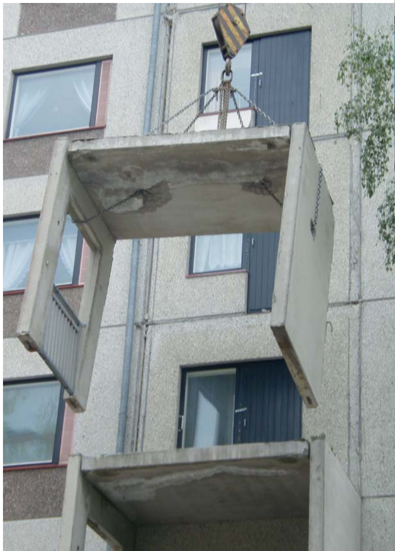
Elemettiparvekkeiden purkaminen on nopeaa ja varsin häiriötöntä verrattuna perinteiseen piikkaamiseen.
