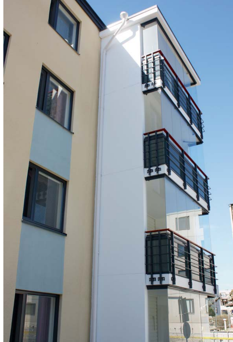
As Oy Riihentuvan parvekekorjauksissa rakennuksen yleisilmettä kohotettiin mm. ulkoseinien eristerappauksella sekä PARMAParvekkeilla. Pääurakoitsijana kohteessa toimi MV-Maalaus Oy.
