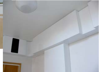
Oululaisessa Asunto Oy Kotkansulassa uudet kupariputket sijoitettiin kotelointeina kiinteistön porrashuoneisiin.
