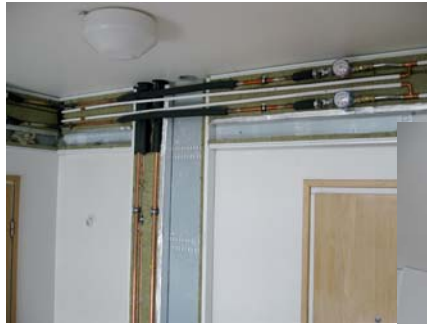
Oululaisessa Asunto Oy Kotkansulassa uudet kupariputket sijoitettiin kotelointeina kiinteistön porrashuoneisiin.
