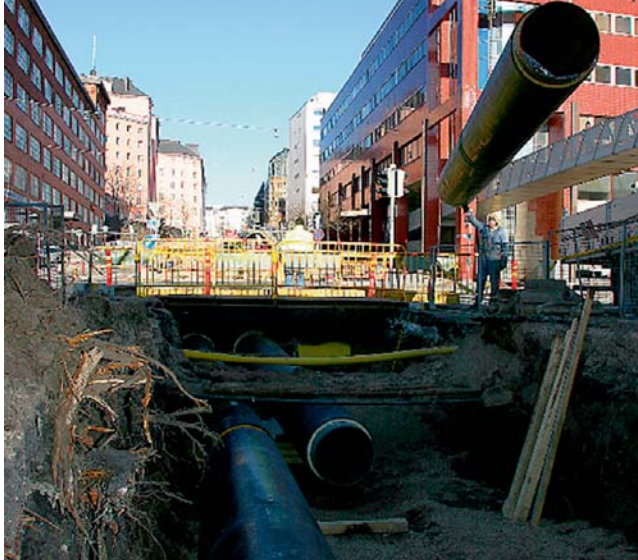
Kaukojäähdytysverkkoa rakennetaan.
