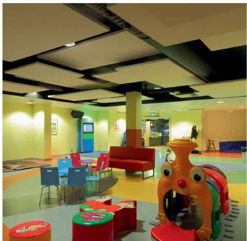
Leijuvat Ecophon Solo -akustiikkalevyt pystyttiin ripustamaan kattoon juuri sille korkeudelle, mille putkistot ja ilmanvaihtokanavat sen sallivat.
