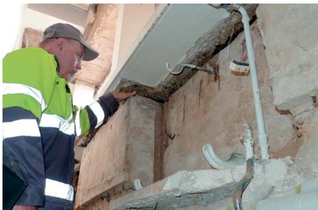
Selostamotilojen seinä- ja palkkirakenteista löytyi monenlaisia kosteusvaurioita, jotka oli korjattava.
