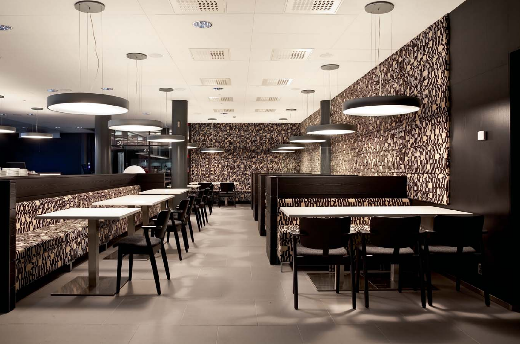
Itulan säteilyelementtien asennus, sekä passiivikasettien asennus Itulan säteilyelementtien väleihin / Forssan Sisärakenne Oy. Sohvajärjestelmät ja seinäpaneelit / Roltrade Oy.
