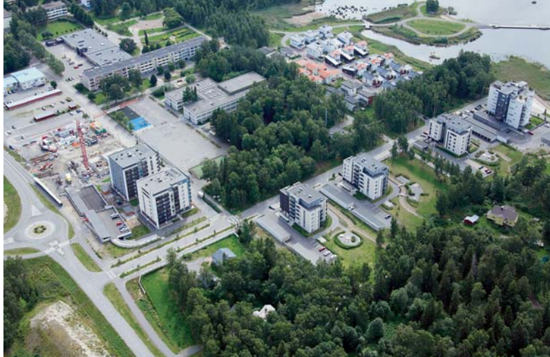
Maalämmöllä ja aurinkoenergialla lämmitettäviä kerrostaloja rakennetaan Vaasassa. Työmaa näkyy kuvan vasemmassa reunassa.
