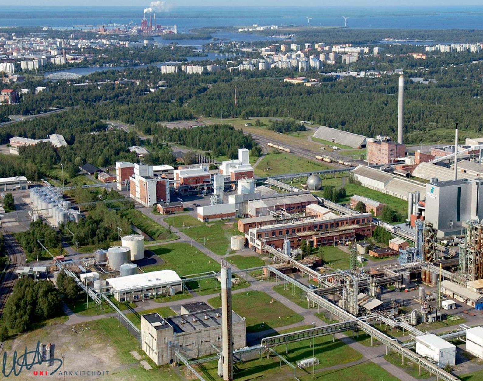
Laanilan uusi voimalaitos Oulussa rakennettiin Kemiran tehdasalueelle.
