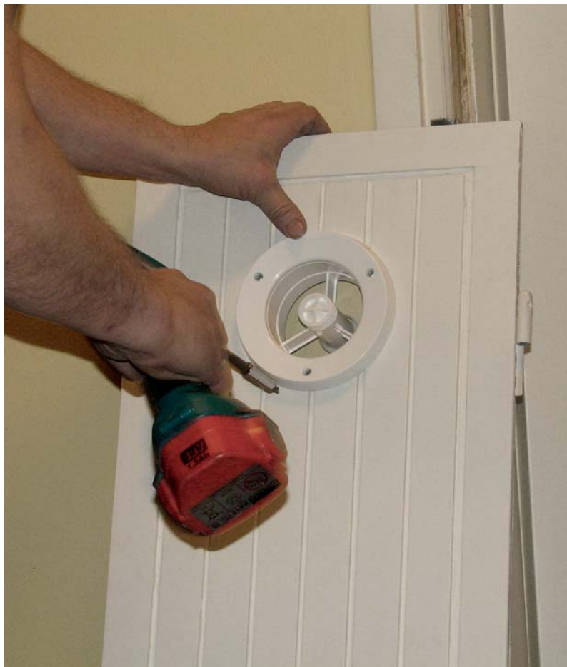
Esimerkiksi puiseen tuuletusluukkuun on helppo asentaa korvausilmaventtiili, jonka ansiosta ilmanvaihto asunnossa paranee merkittävästi.
