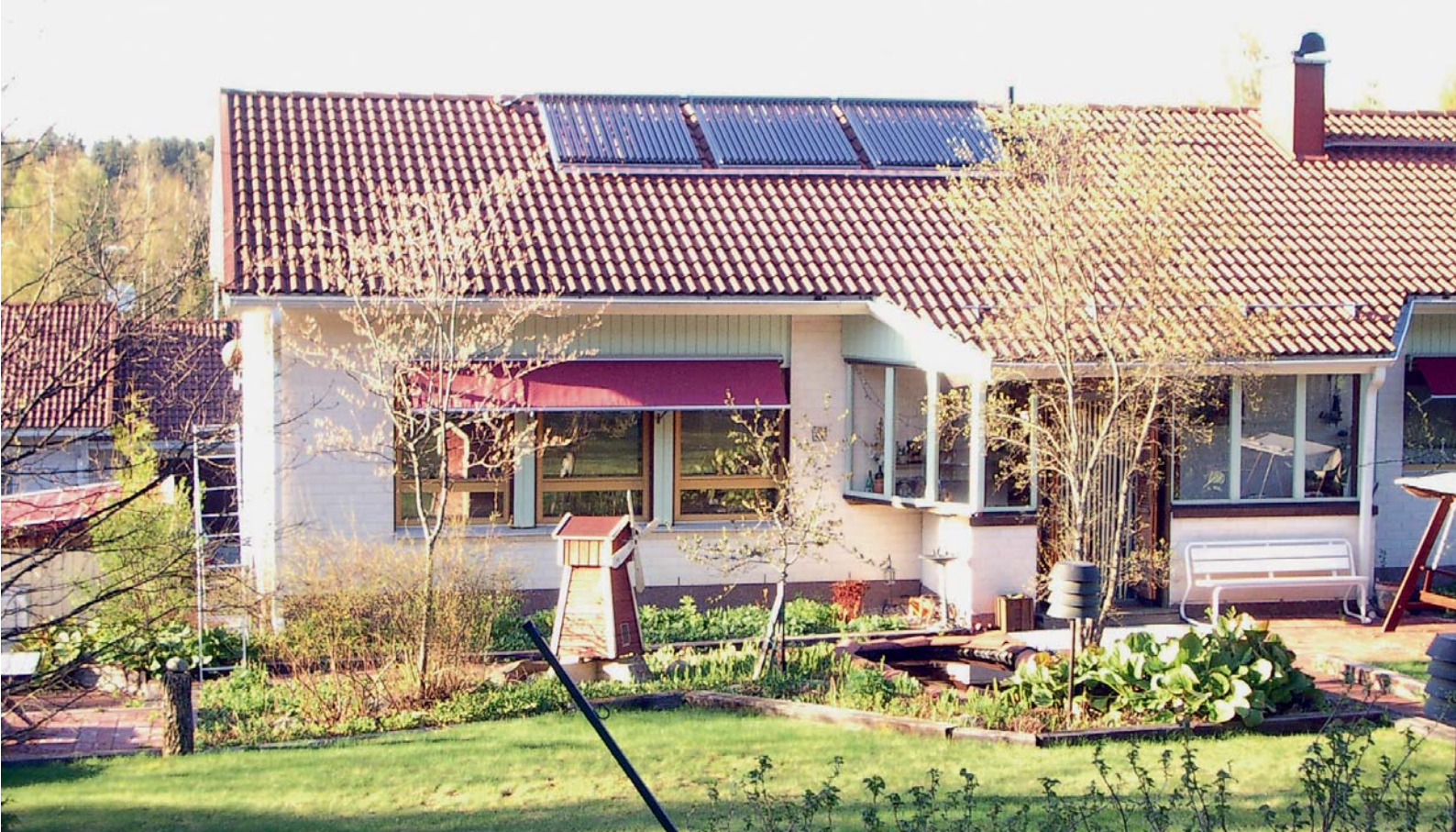
Aurinko-öjljlämmitystalossa aurinkokeräimet on helpointa asentaa harjakatolle.
