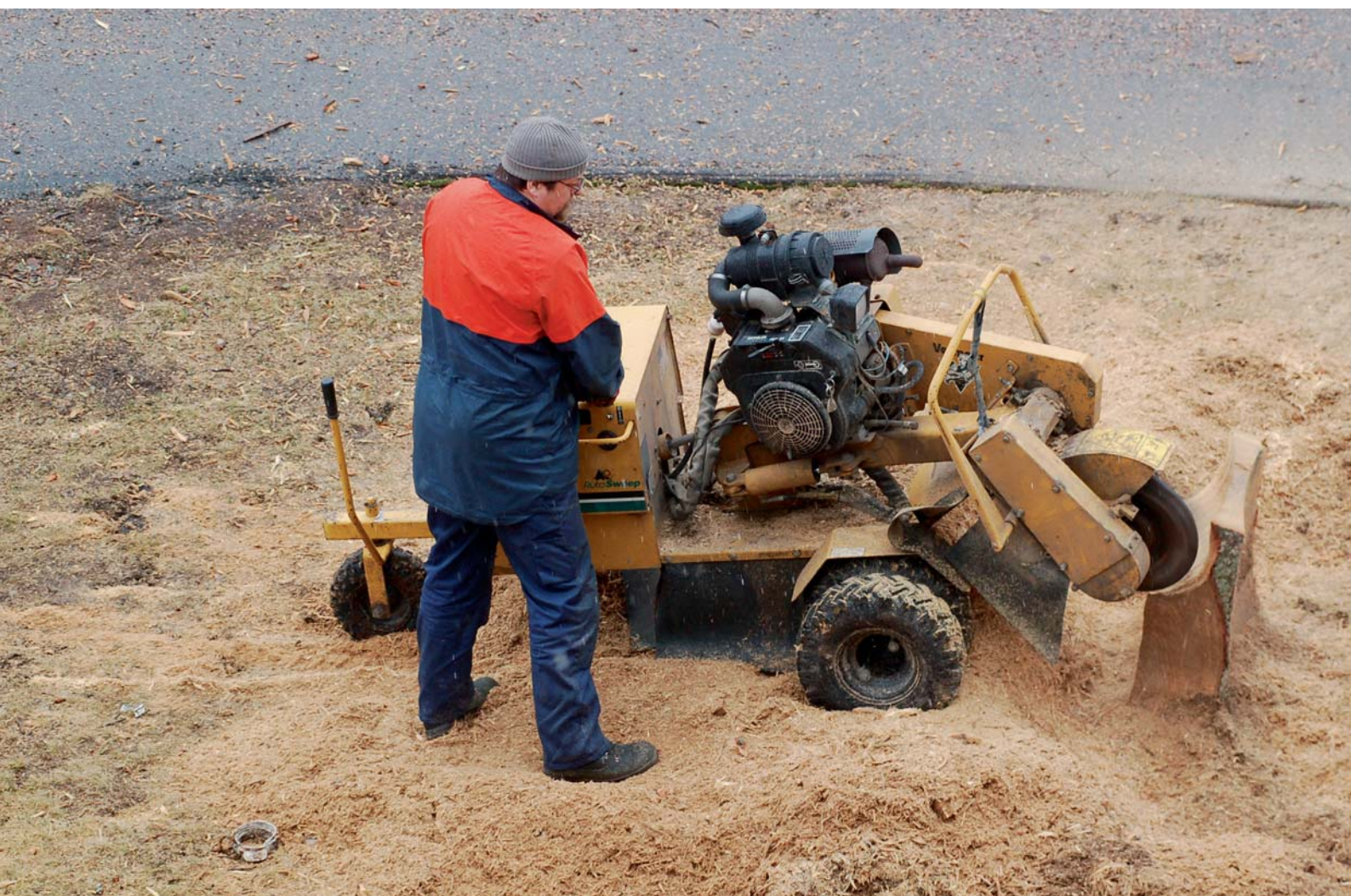
Piha-alueiden kunnossapidossa tarvitaan toisinaan haketuskonetta.
