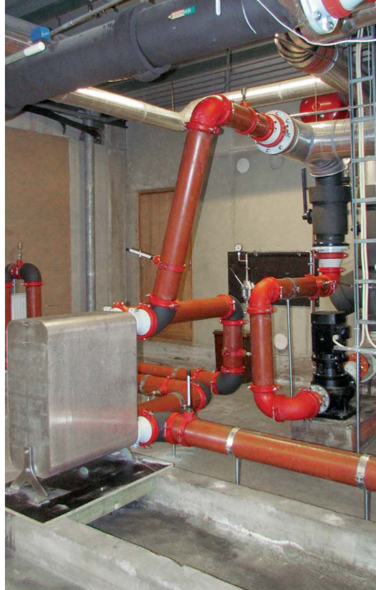
Perustukset paljastavat vanhan ja uuden koko eron. Entinen vedenjäähdytinlaitteisto on purettu pois ja uusi nostettu sen tilalle.
