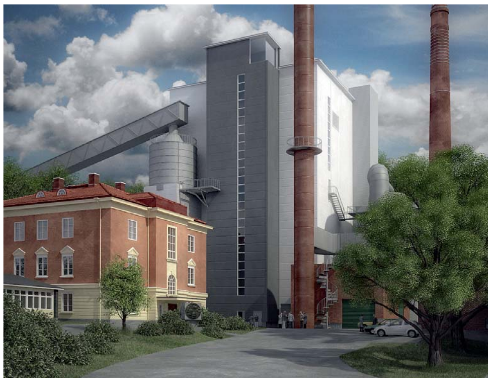
Pohjolan Voiman bioenergiaohjelma sai uuden tulokkaan – Hämeenkyrön laitos on 15. Pohjolan Voiman rakentamista biovoimalaitoksista.
