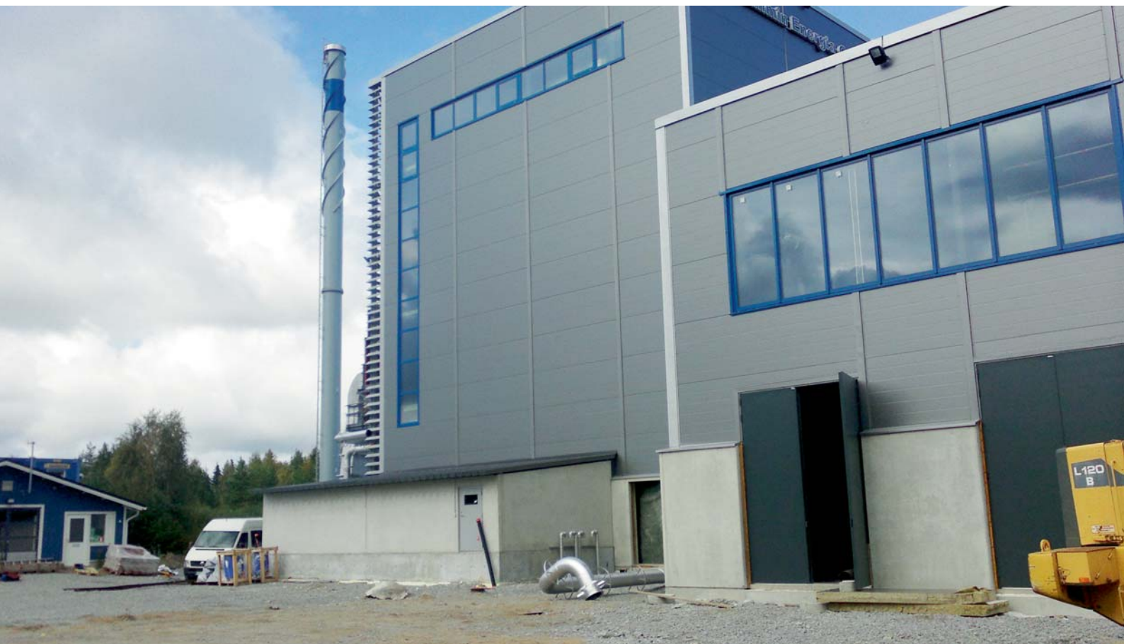
Toholammin Energian pienvoimalaitos
