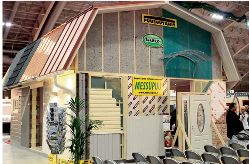
TAMKin rakennustekniikan opiskelijat rakentavat messuille Tuotetalon, jossa esitellään erilaisia rakenteita ja ratkaisuja, sekä sisustuspinta- ja julkisivumateriaaleja.
