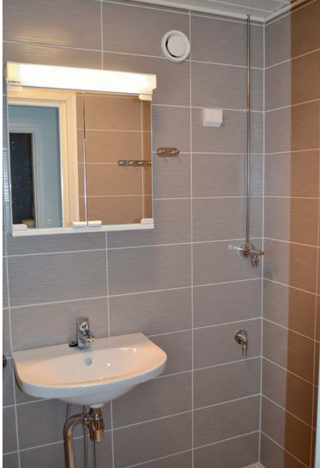
Vesikalusteet uusittiin asuntojen kylpyhuoneissa.
