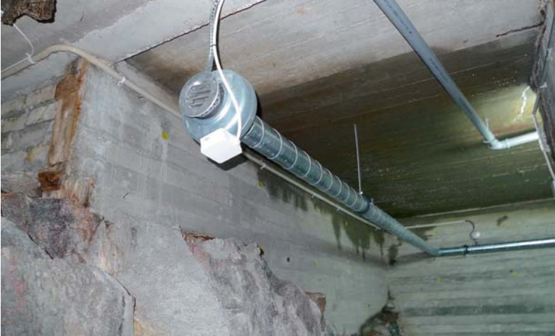
Westendissä kuivauslaitteistoon lisättiin jatkoputki, joka ohjaa kuivaa ilmaa ryömintätilan perukoille.
