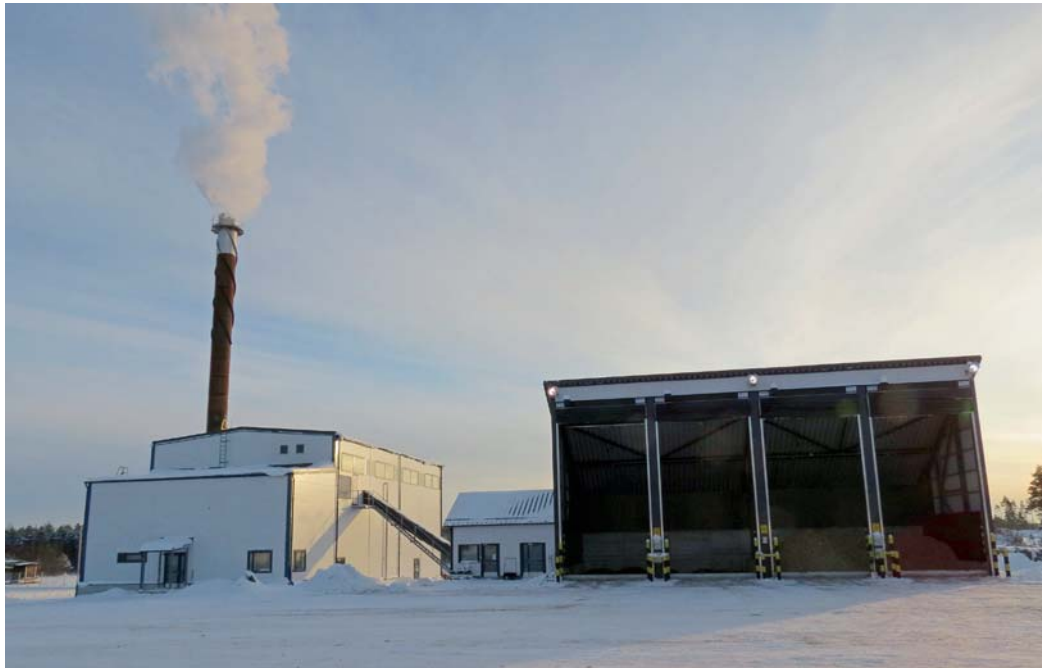
Karjaan Kaukolämpö Oy:n bio-lämpökeskus käynnistettiin 20.11.2012.
