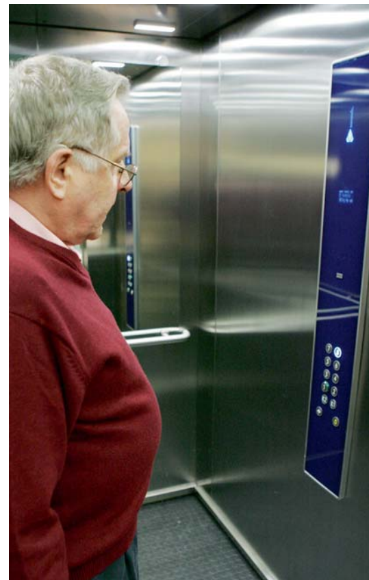
Adjutantin hissit ovat energiatehokkaita ja älykkäitä. Ne muistavat asukkaan asuinkerroksen ja ottavat talteen energiaa hissien laskeutuessa.
