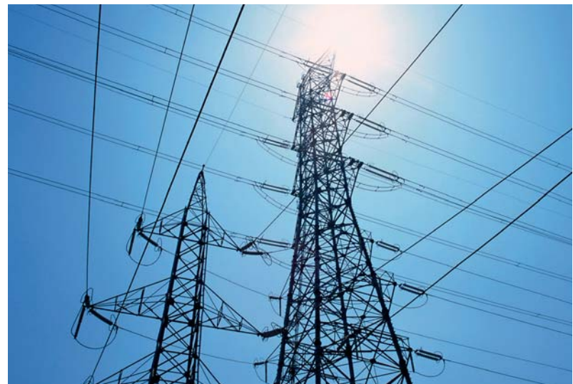
Toshiban siirto- ja jakeluverkon tuotteet ovat osa Landis+Gyrin tuotevalikoimaa.
