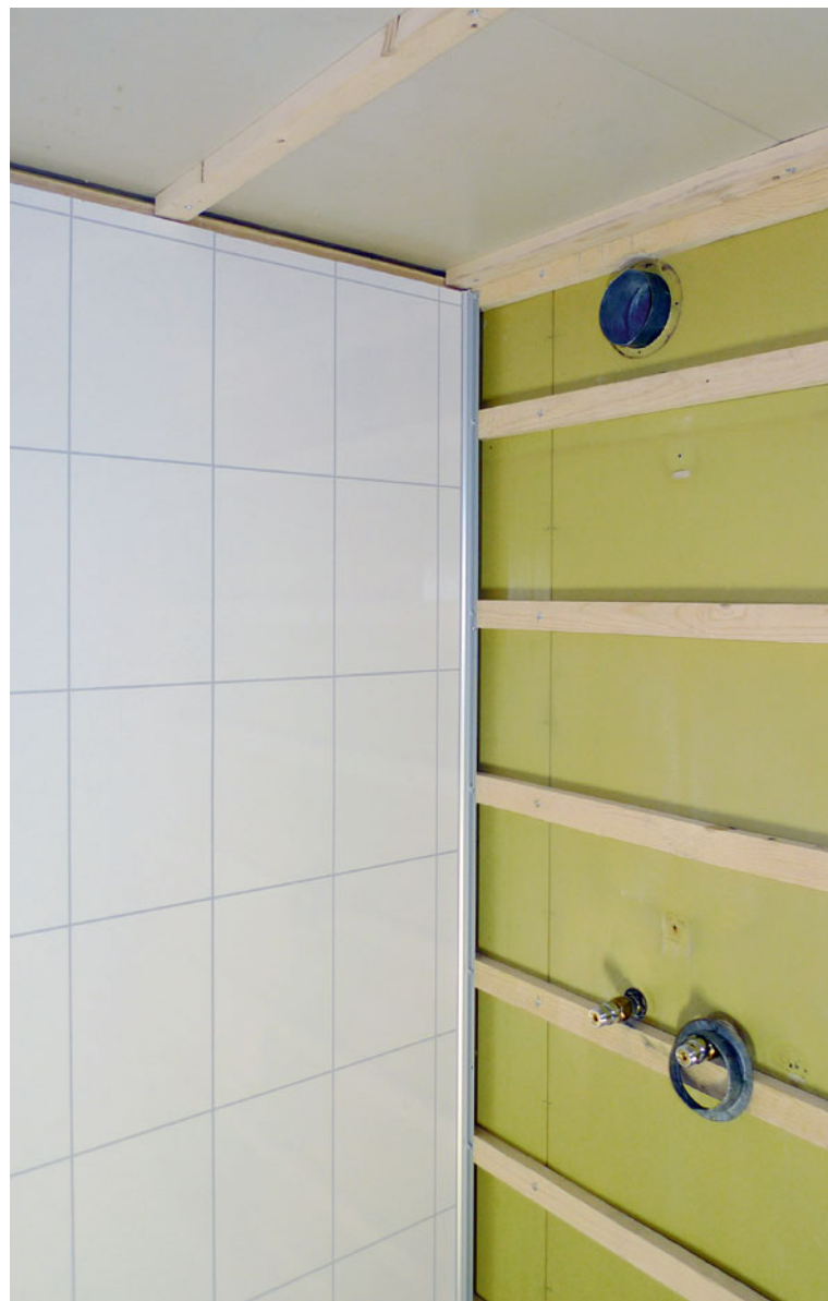
Yksi laminaattilevyseinä on saatu valmiiksi nurkkalistaan asti.
