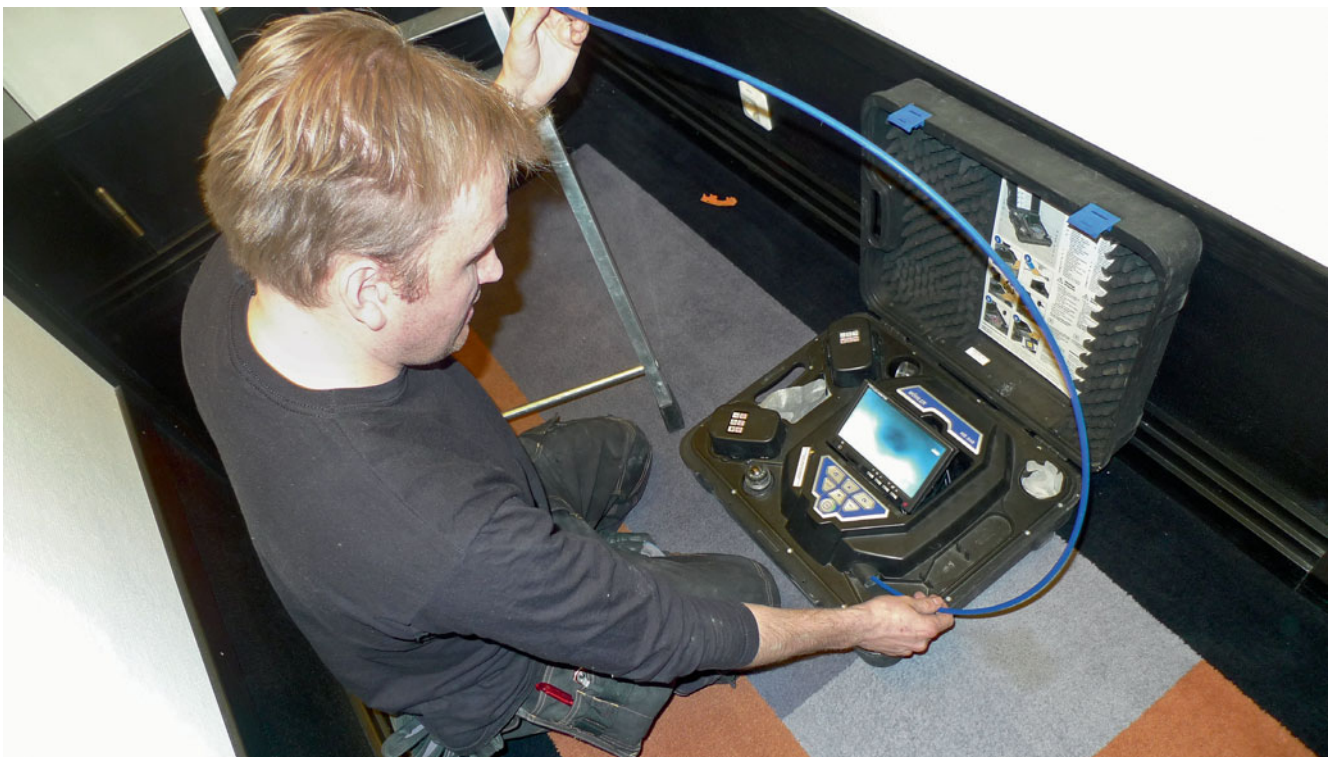
Pasi Wallenius tutkii ilmanvaihtohormissa olevan videokameran lähettämää kuvaa.
