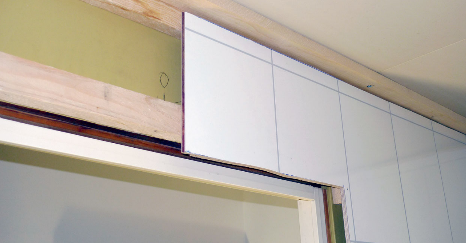
Levyjä asennetaan kylpyhuoneen oviaukon yläpuolelle.
