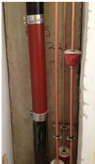
Putkihormi, jossa vesijohdot uusittu sekä viemäri sukitettu.
