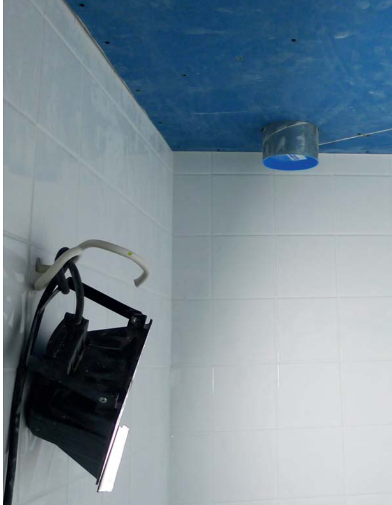
Kylpyhuoneen ilmanvaihtohormi on kunnostettu valmiiksi.
