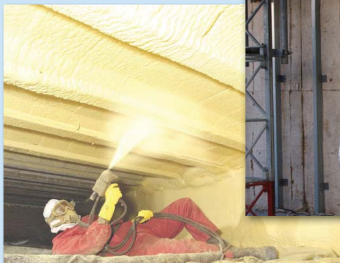
Alapohjan ja seinän ruiskutusta.
