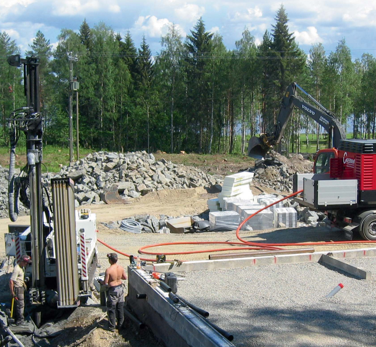
Lämpökaivon poraamisessa tarvittava paineilma tuotetaan kompressorilla.
