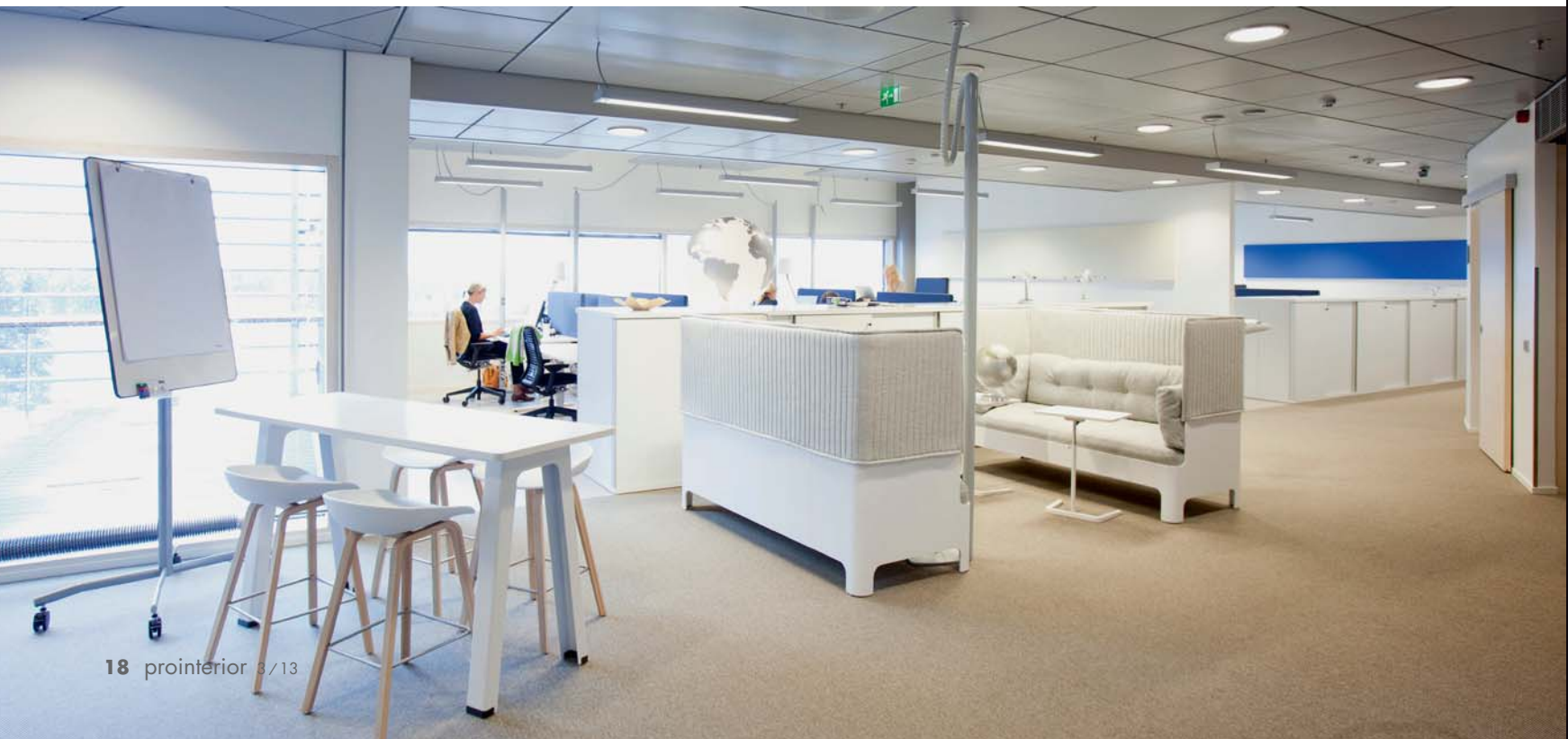
Mood Works Oy Ltd on toimittanut mittatilauksena valmistettuja, villakangaspintaisia akustiikkapaneeleja avotilojen seinille. Toimistokerroksissa on alakattoina Inlookin akustiset harmaat metallikasetit.
