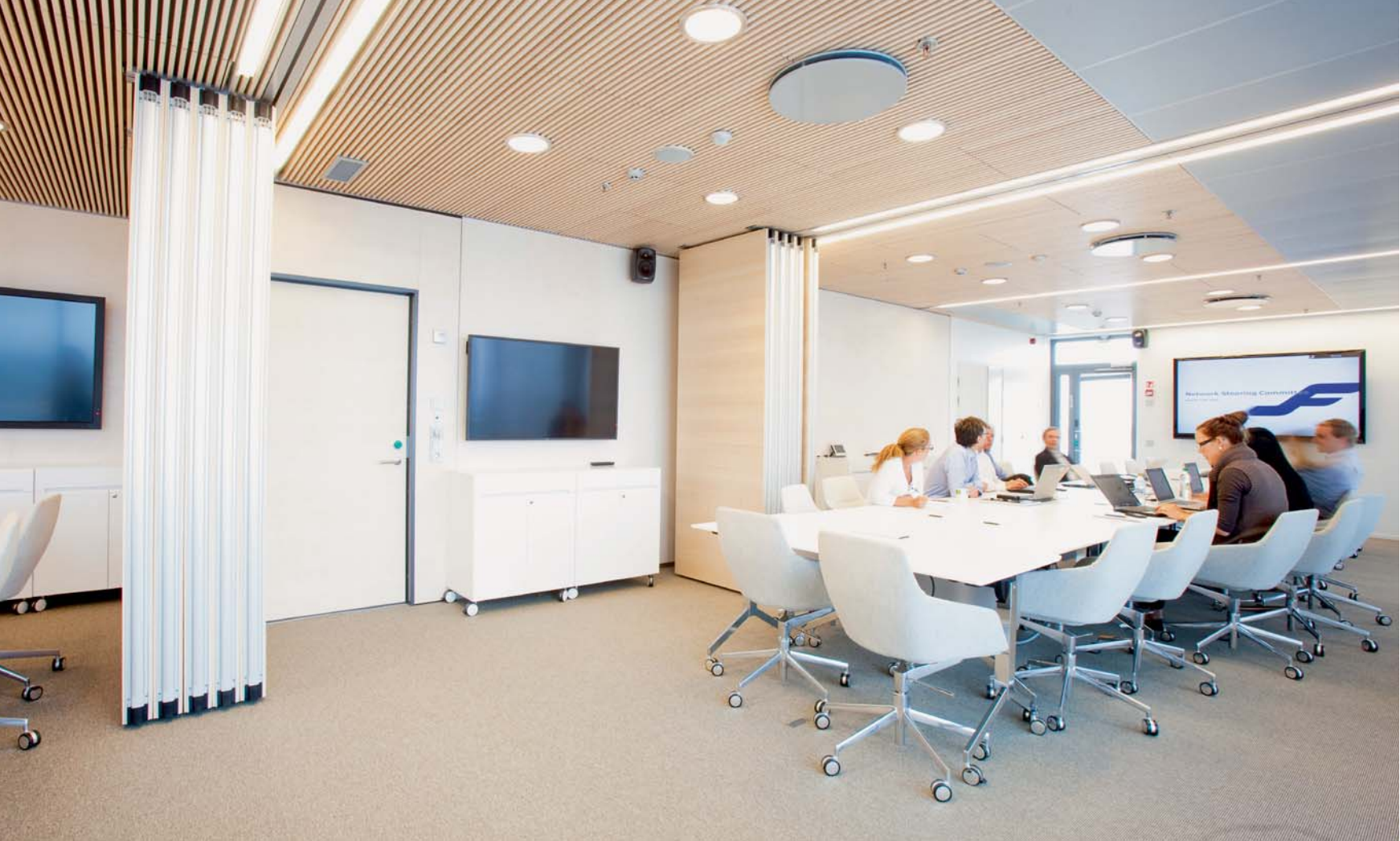
Inlookin Linear WP-katot soveltuvat hyvin neuvottelutiloihin akustisen huovan ja äänenvaimennuslevyn ansiosta. KT Interior Oy:n toimittamissa sähköisesti tiivistyvässä Dorma Moveo® -siirtoseinäelementeissä on pintamateriaalina koivuinen vaakaviilu. Elementit ovat seinän auki ollessa "parkissa" tilan reunassa.
