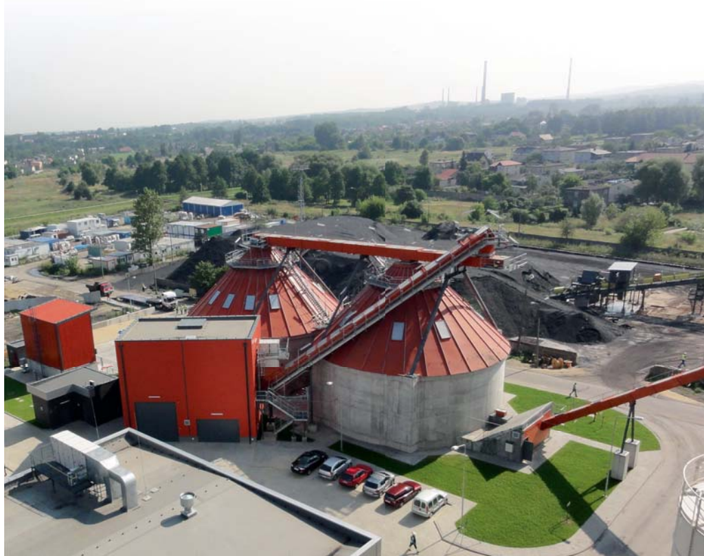
BMH:n rakentama viljellyn pajun ja metsähakkeen vastaanotto- ja käsittelylaitos. Biomassan käyttöönoton jälkeen vanha hiilivoimala on pystynyt merkittävässä määrin vähentämään kivihiilen käyttöä.
