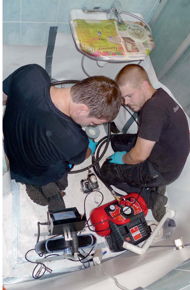
Sukittua putkea kuvataan viemärikameralla A-portaan yläkerran asunnon kylpyhuoneessa. Asentajat seuraavat tilannetta pienestä videomonitorista.
