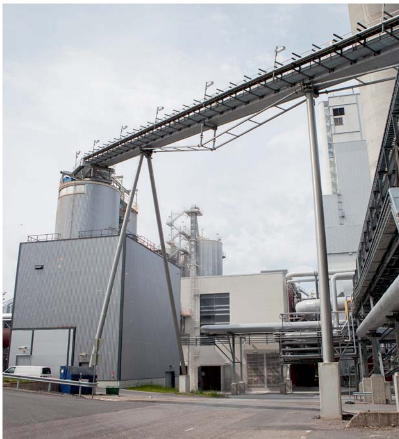
Kaasutinlaitos, taustalla meesauuni. Ylhäällä oleva ketjukuljetin vie kuivan biomassan kaasuttimeen.
