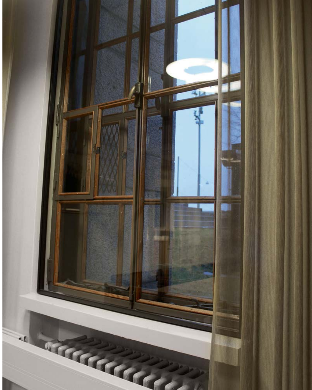
Alkuperäisiä ikkunoita on parannettu vedottomiksi lisäämällä sisälle kolmas lasi. Sirén ohjeisti kuivaamaan ikkunoiden välit sateen ja lumimyrskyn jälkeen. Eduskunnan rakennuksen ylipaine on kuitenkin auttanut pitämään sään vaikutukset ja pölyt ulkopuolella.
