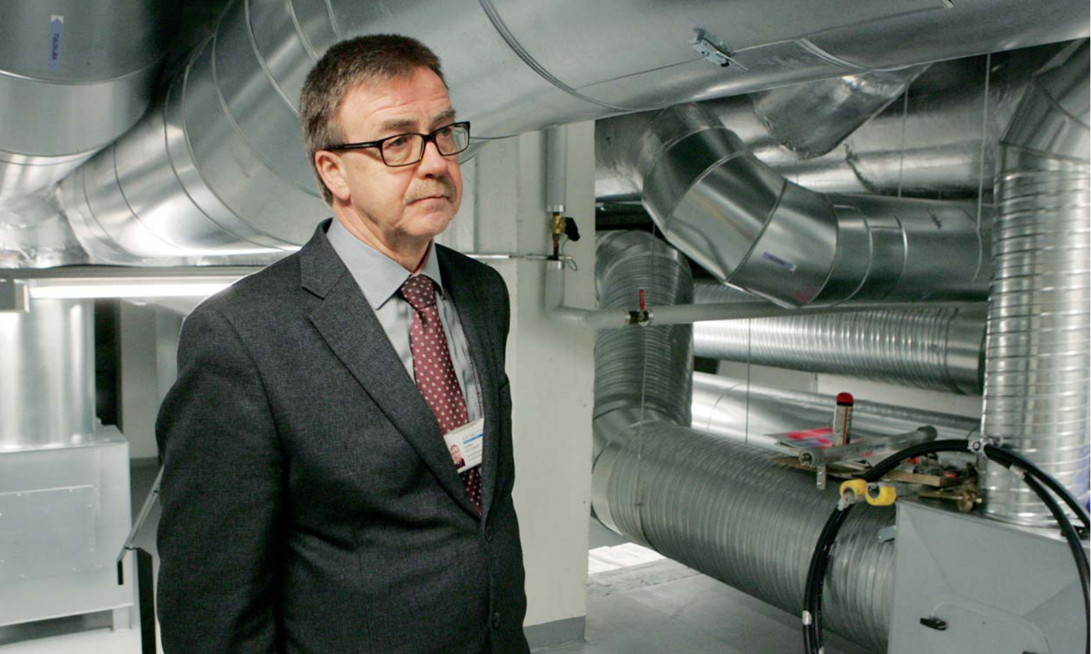
Hannu Peltonen maan alle louhituissa teknisissä tiloissa.
