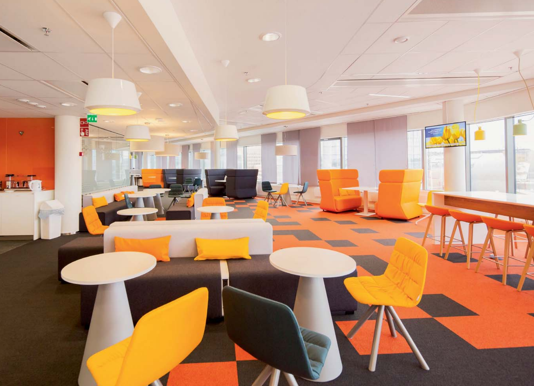
Tilojen läsnäoloon ja vakiovaloon perustuva energiaa säästävä valonohjausjärjestelmä / Helvar Oy.
