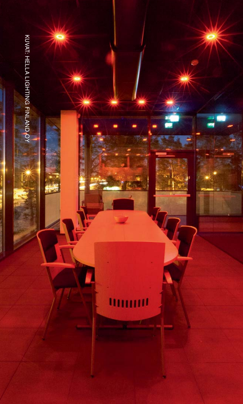
Neuvotteluhuoneen valaisimet: HELLA Lighting Finland Oy:n Spot S102 ambient-toiminnolla. Valaisimen päävalon teho on 9W ja ambientin teho 0,4W.
