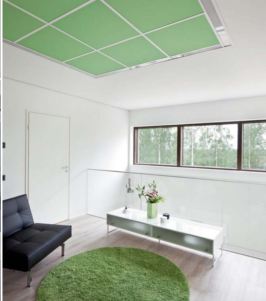
Oleskelutilassa limen vihreä akustiikkakenttä, jota reunustaa LED-valolistat. Akustiikkalevynä käytetty Ecophon Focus A 600 x 600 mm.
