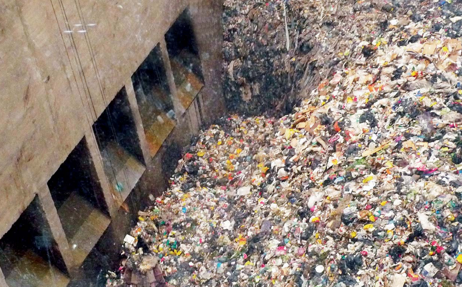
Pollettavat jätteet kootaan betonibunkkeriin, jonka korkeus on 38 metriä.
