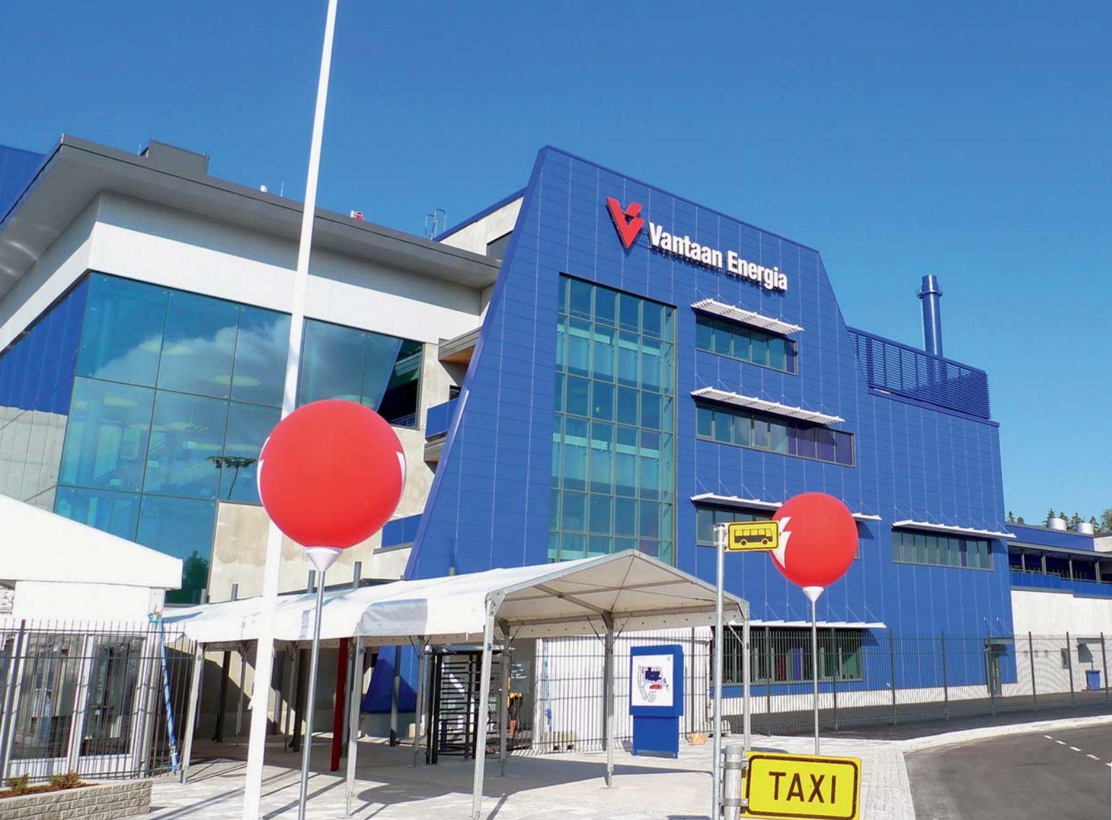
Vantaan Energian uusi voimalaitos tuottaa suuren osan kaupungin sähköstä ja kaukolämmöstä.
