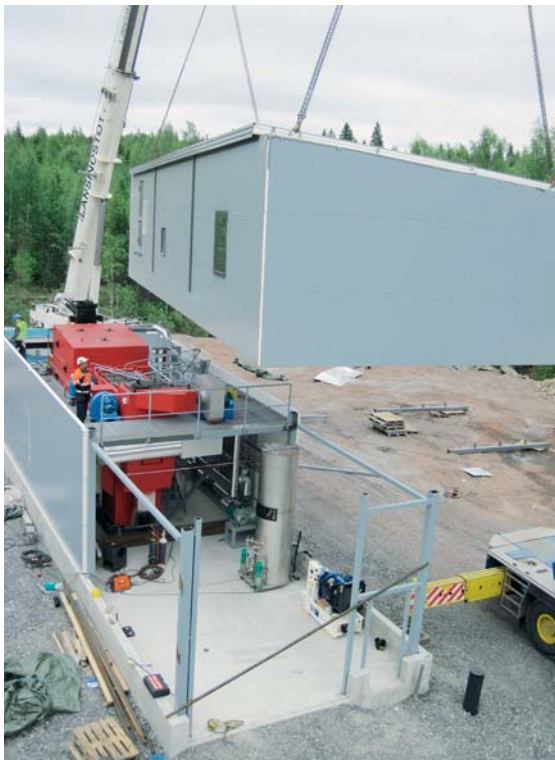
Lohkojen nostot kuljetuslaveteilta aloitetaan aamulla.
