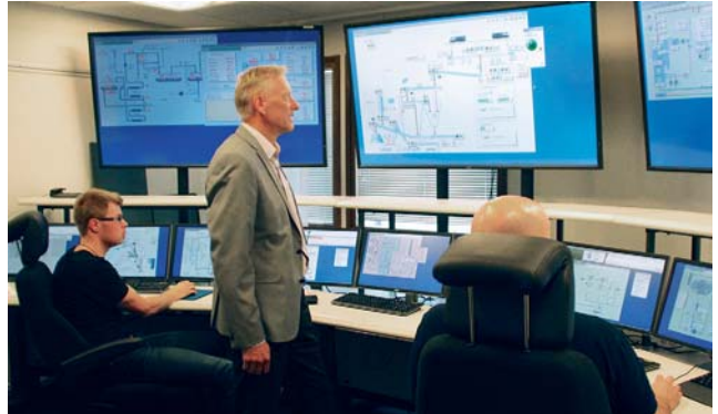
Valvomo on mitoitettu siten, että siellä pystyy työskentelemään kolme operaattoria kerrallaan. Tavoitteena on, että tässä valvomossa valvotaan vuoden lopulla samoilla silmäpareilla sadan erillisen laitoksen toimintaa. Kuvassa vasemmalta Jouni Hirvonen, Jouko Latvakangas ja Ville Jaakkosela.
