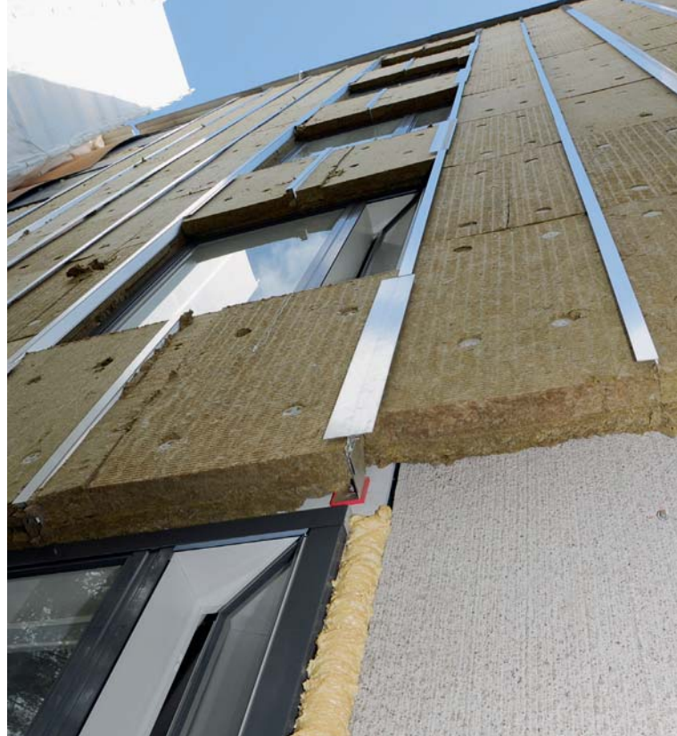
Uusien julkisivulevyjen alle lisättiin 12 cm:n paksuinen lämpöeristekerros.
