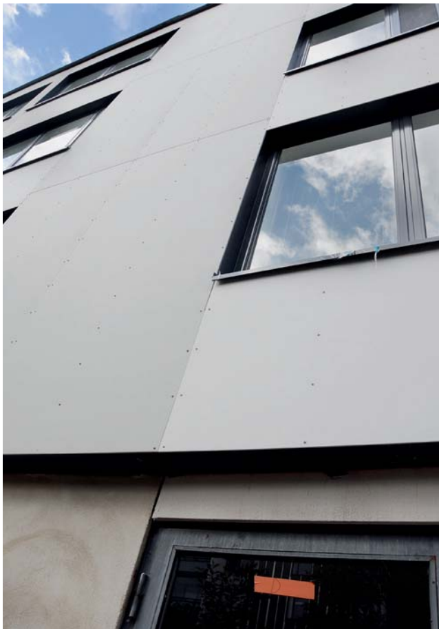
Julkisivuremontin yhteydessä vaihdettiin myös ikkunat.
