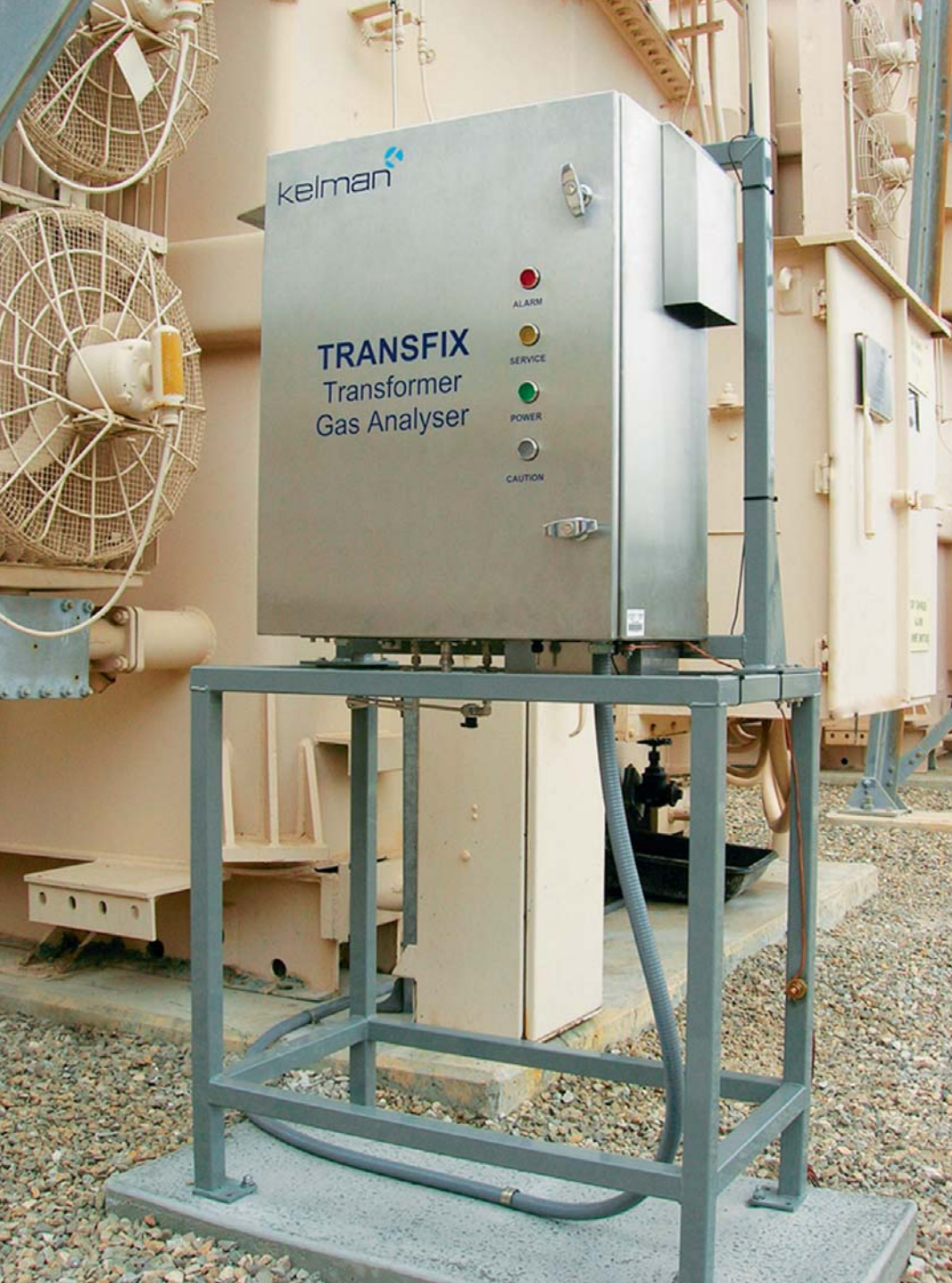
Kiinteästi asennettava Kelman Transfix -tyyppinen online-kaasuanalysointilaitteisto.
