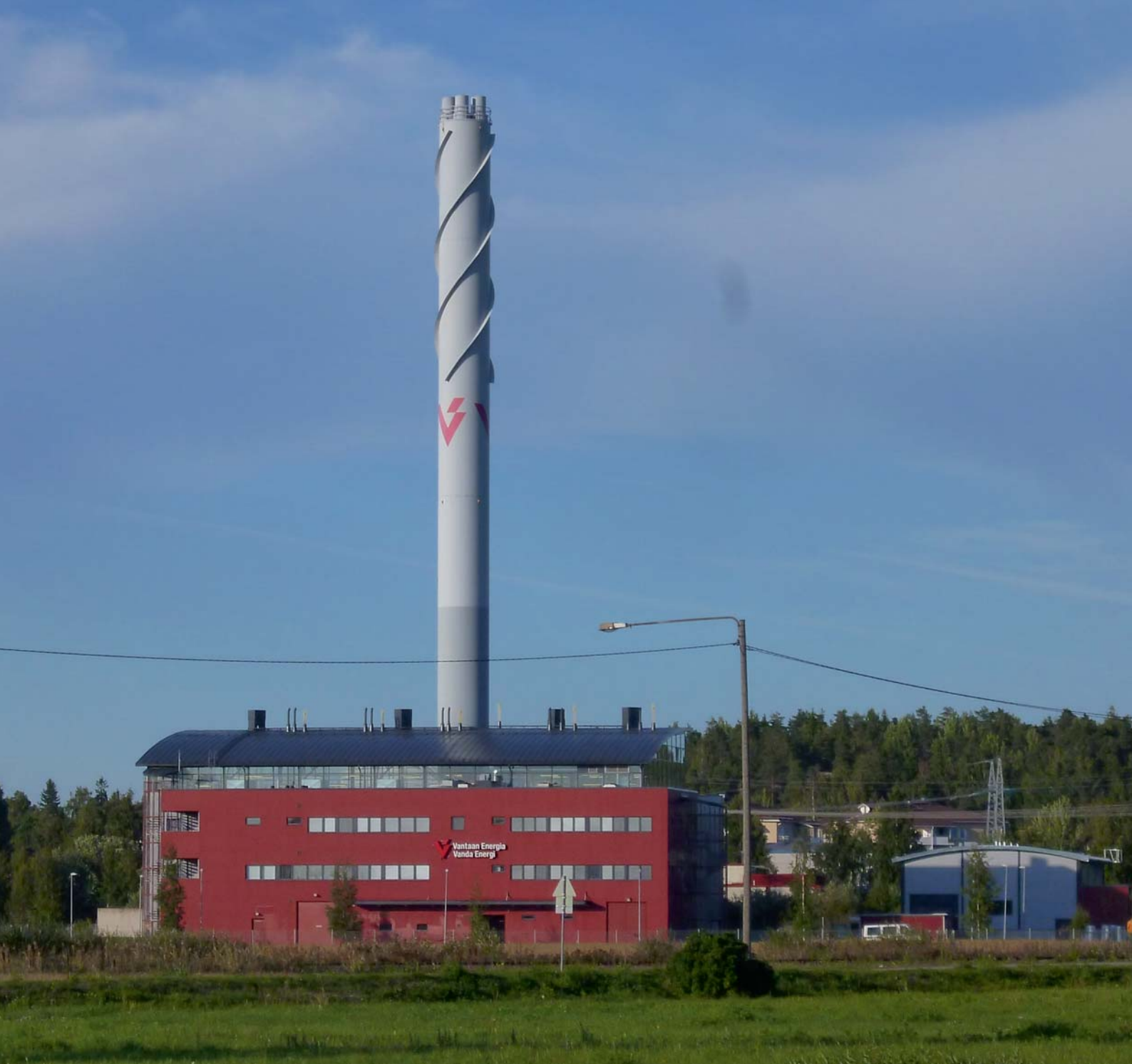
Hakkilan Maarinkunnaksen lämpökeskuksen poltin uusitaan viimeistään lähivuosina. Laitoksessa käytetään öljyä varapolttoaineena.
