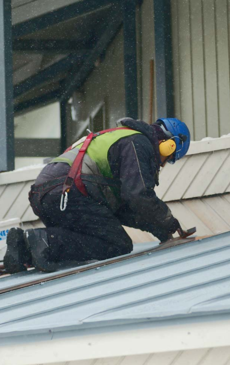
Kattotutka Oy:n peltiseppä Mohammed Elkrich viimeistelee kattopellin kiinnitystä yli 16 vuoden kokemuksella.
