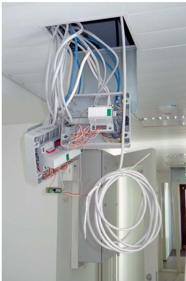
Väestöliitto muuttaa Innotaloon alkukesällä. Tilat on saneerattu ja talotekniikan asennukset loppusuoralla.
