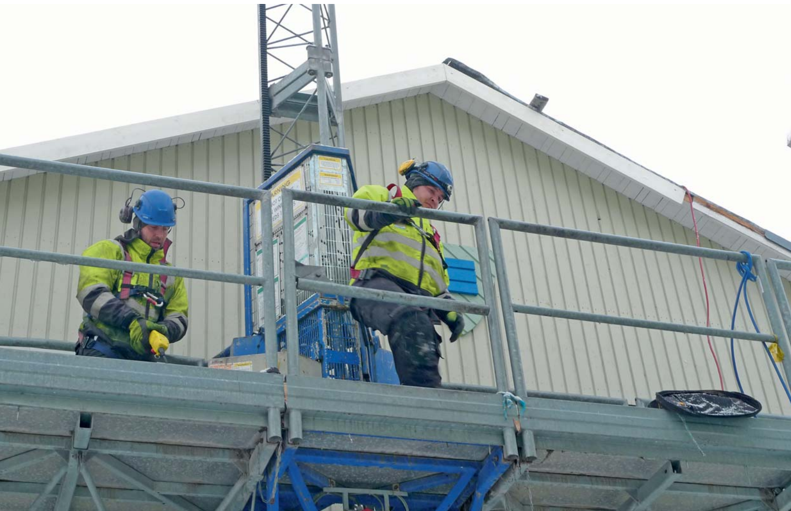
Mastolavanostinta käytetään kattotöiden tavara- ja henkilökuljetuksissa.
