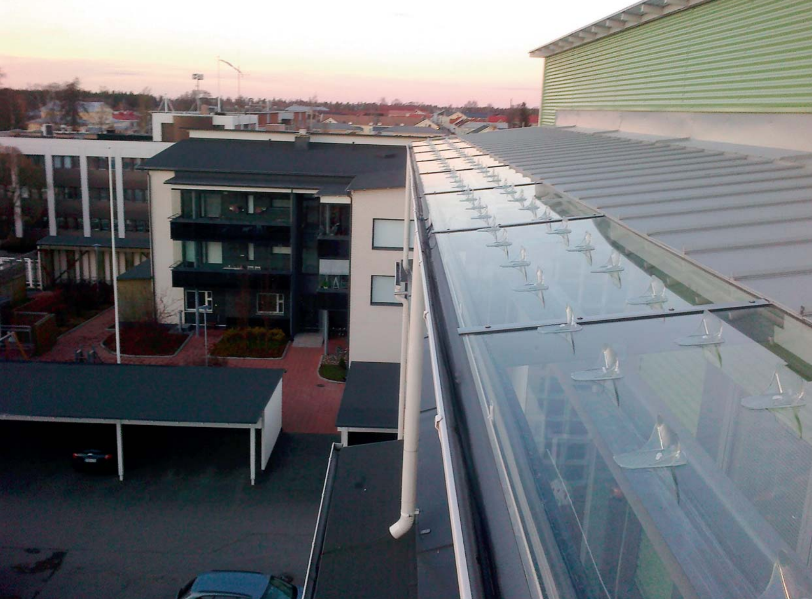
Kulo Lumieste liima-asennettuna parvekkeen lasitukselle.
