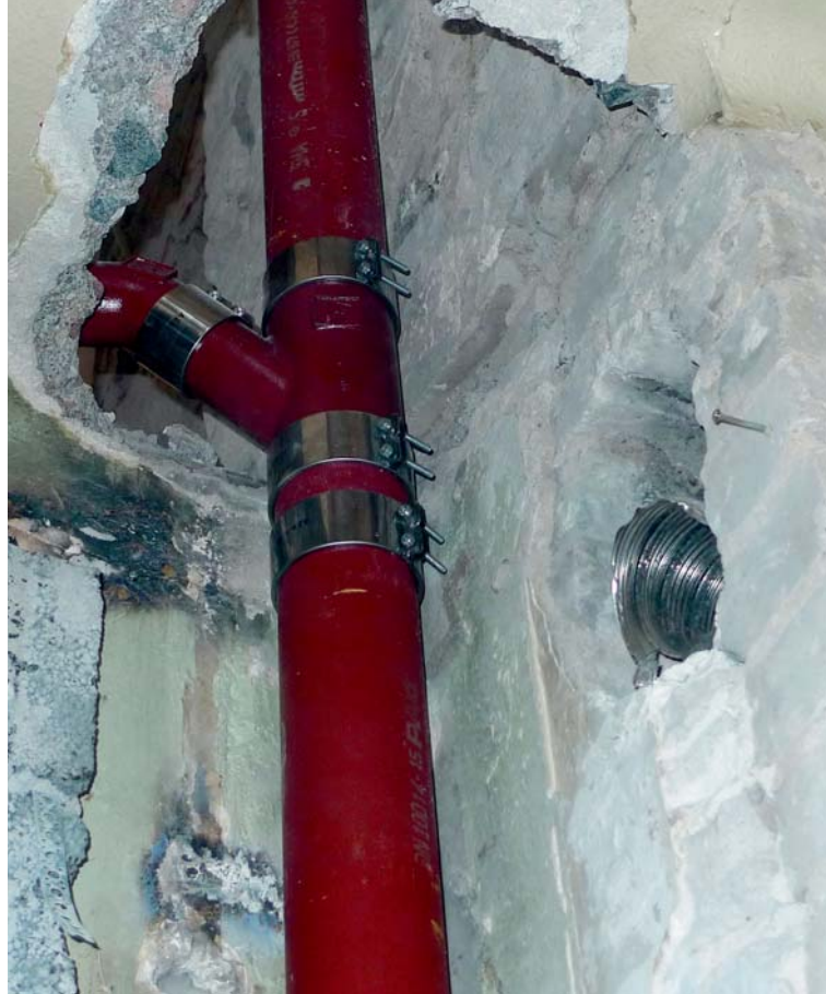
Taloon asennetaan remontin yhteydessä uudet valurautaiset viemäriputket.
