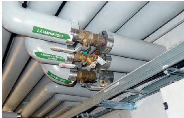
Peruskorjaushankkeen yhteydessä Yläkartanontie 20:ssä uudistettiin viemäriputkien lisäksi myös kiinteistön käyttövesiputket.
