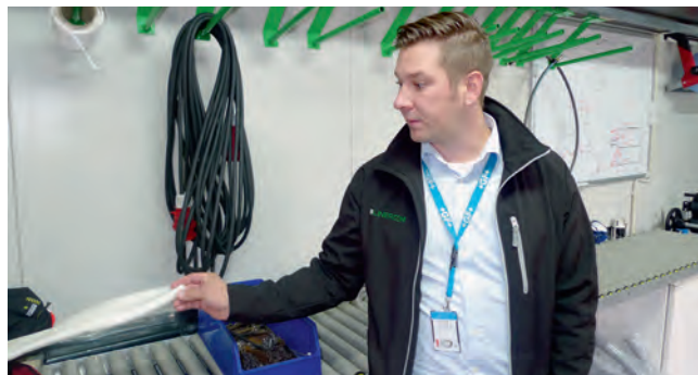
Arto Mäkinen kertoo putkiin asennettavan sukan esikäsittelystä. Tämä työvaihe tehdään työmaakontissa, joka on urakan ajaksi sijoitettu kiinteistön pihalle.
