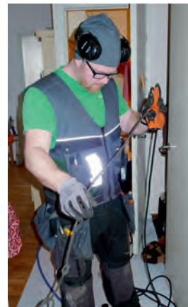
Asentaja Petri Nurminen valmistautuu putkitöihin asuinhuoneistossa.
