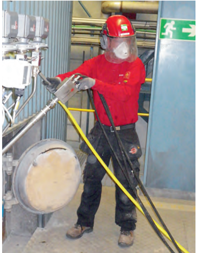
Bang & Clean-räjäytyspuhdistus on ollut käytössä noin 10 vuotta. Sen on kehittänyt sveitsiläinen Bang & Clean Technologies AG, ja sillä on puhdistettu satoja kattiloita Euroopassa. Pohjoismaissa menetelmää on käyttänyt menestyksekkäästi AB Sprängsotning, joka on nyt osa Deleteä.
