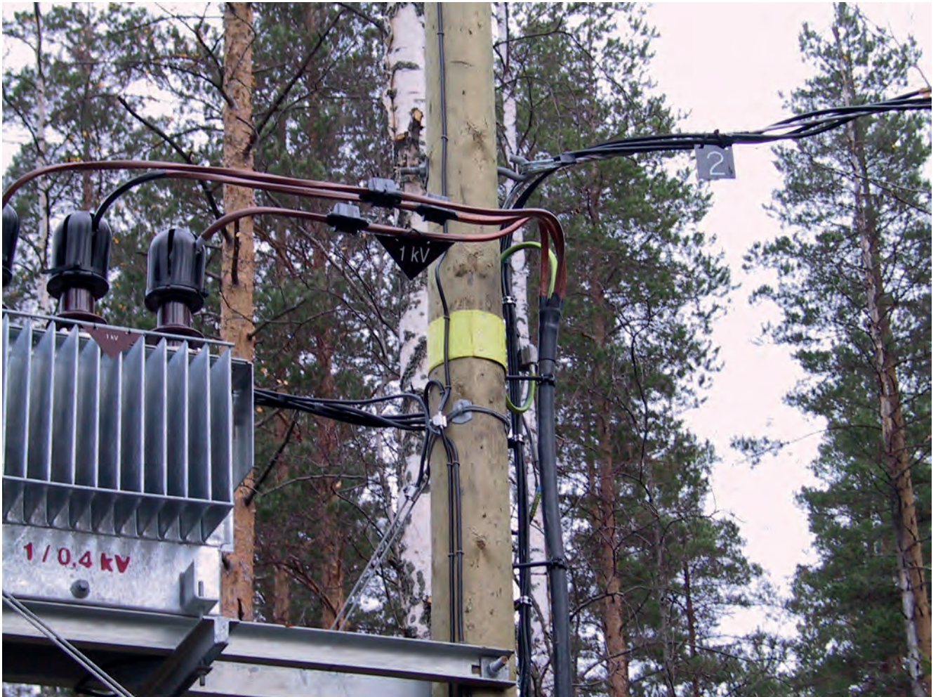
Järvi-Suomen Energia Oy:n verkostosta yhden kilovoltin verkkoa on tällä hetkellä 1150 kilometriä. Johdoista hieman yli puolet kulkee ilmassa.
