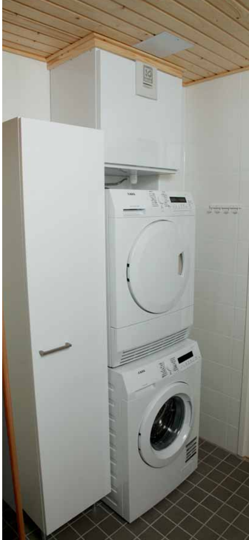
Asukkaat elävät eri rytmissä eri asunnoissa. Huoneistokohtaisella ilmanvaihdoilla varmistetaan riittävä ilmanvaihto ja kosteuden poisto juuri kyseisen asukkaiden tarpeiden mukaan.
