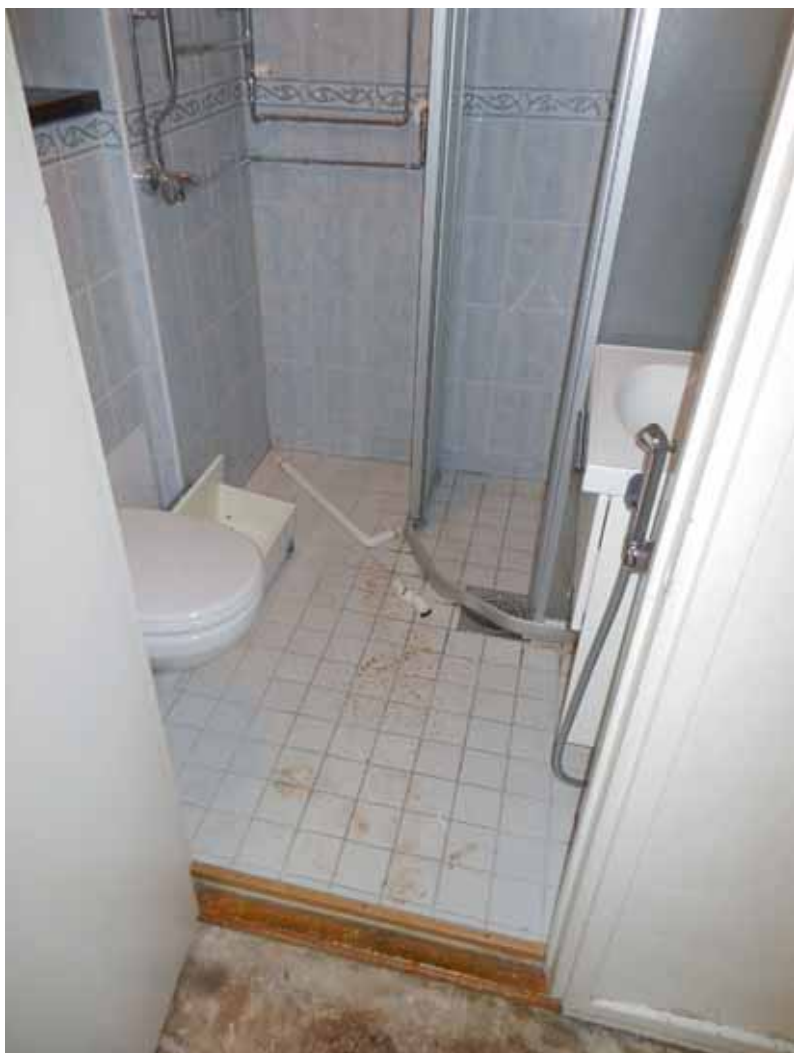
KUVA: VARSINAIS-SUOMEN KIINTEISTÖKUIVAUS OY
