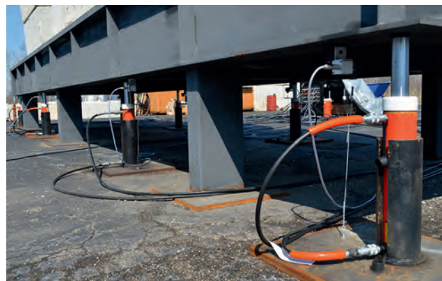
SPX POWER TEAM -liikkeenohjausjärjestelmä nostamassa varovasti suurta muuntajaa.
