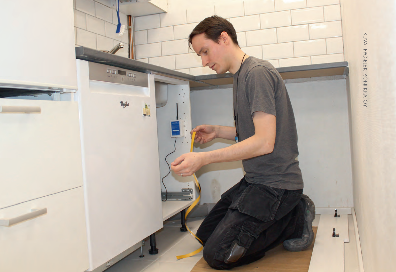
Tekninen asiantuntija Kimmo Kontinen asentaa vesivuotohälytintä asiakkaalle.
