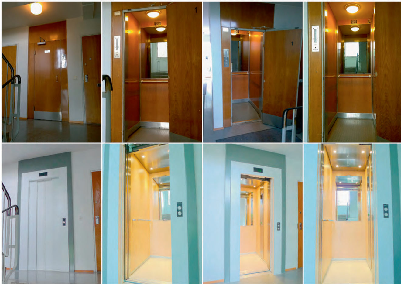
Asunto Oy Kerttulinkalliossa Turun Kellonsoittajankadulla uusittiin 9-kerroksisen talon vanhat hissit kokonaan. Ylärivissä vanhat kääntöoviset ja monin tavoin turvattomat hissit. Alarivissä vanhoihin kuiluihin sovitettut modernit automaattioviset hissit.
