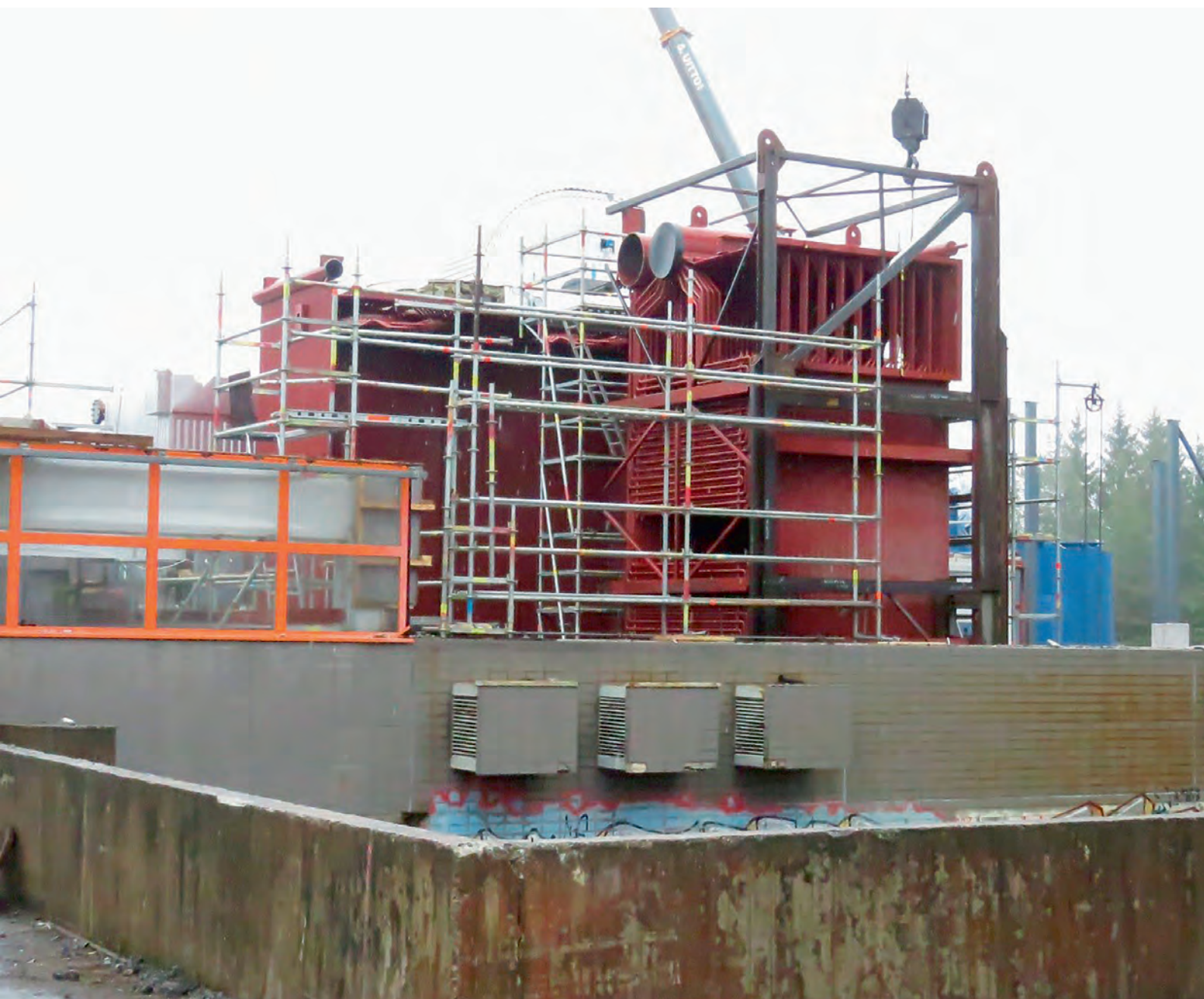
90 MW kattila – yksi konvektioloikko vielä nostamatta – rakennuksen katto poistettu.
