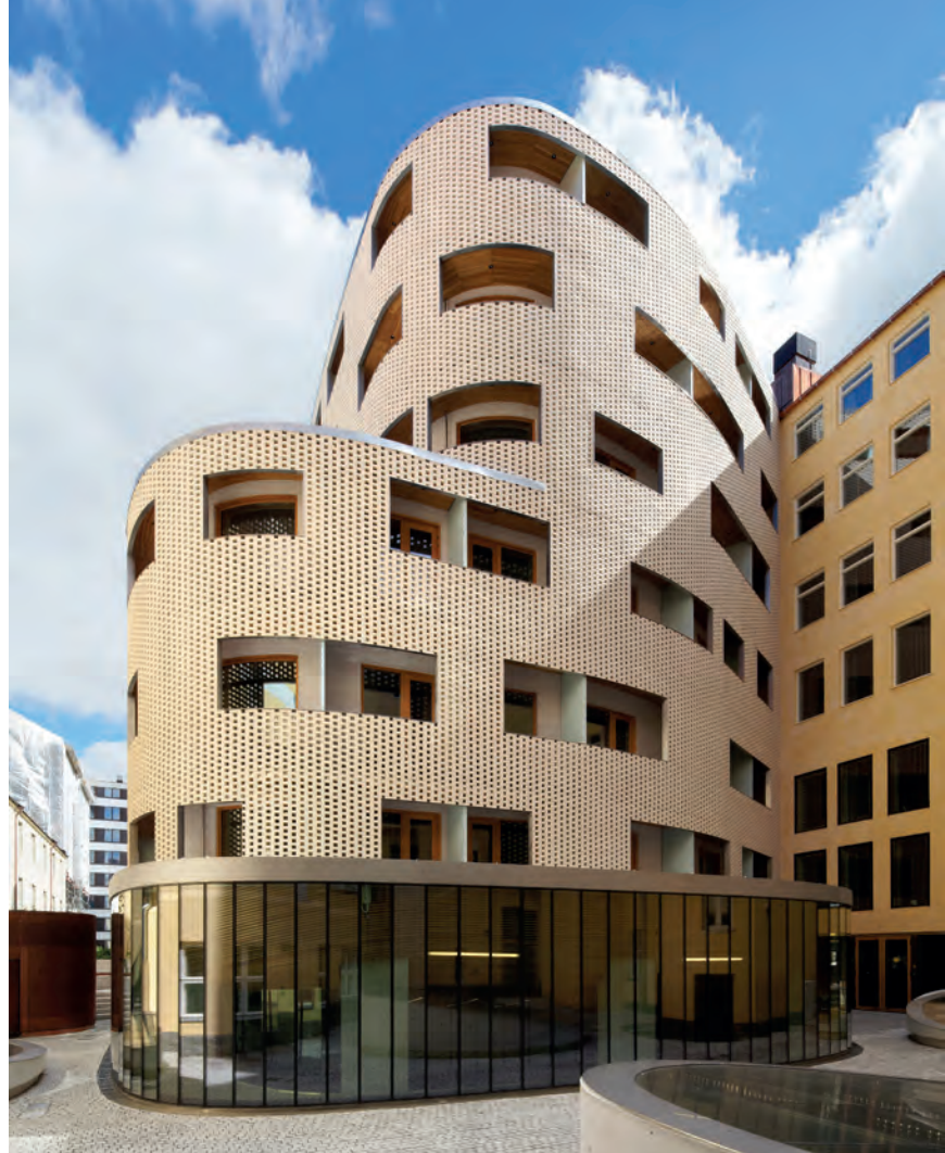
Paasihotellin julkisivussa on Tuohi Retro Pro -erikoistiili, Suomessa valmistettu julkisivutiili kohteen erityistarpeiden mukaisesti.
