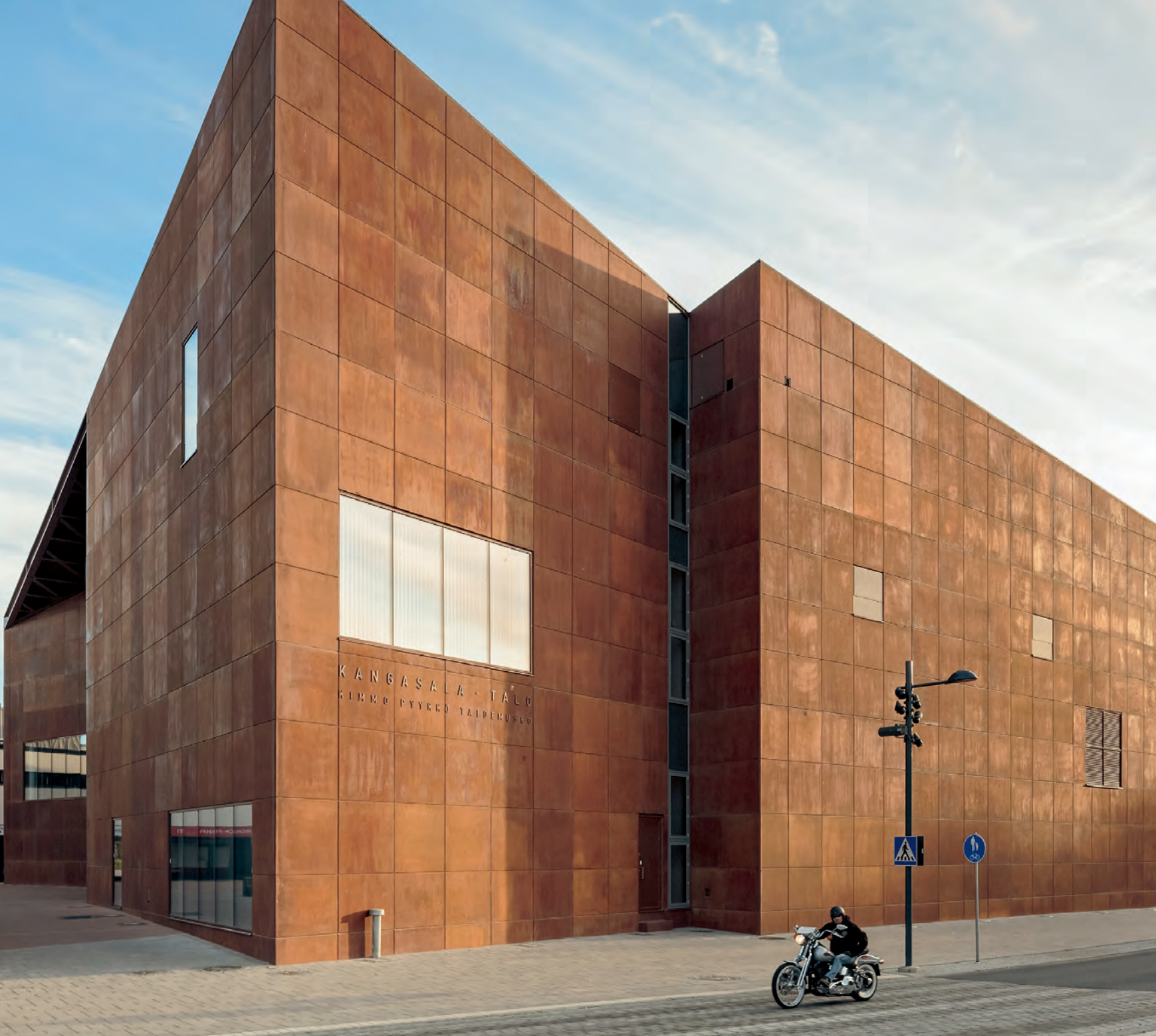
Kangasala-talo. Kangasala. Arkkitehtuuritoimisto Heikkinen-Komonen Oy. Vuoden Betonirakenne 2015.
