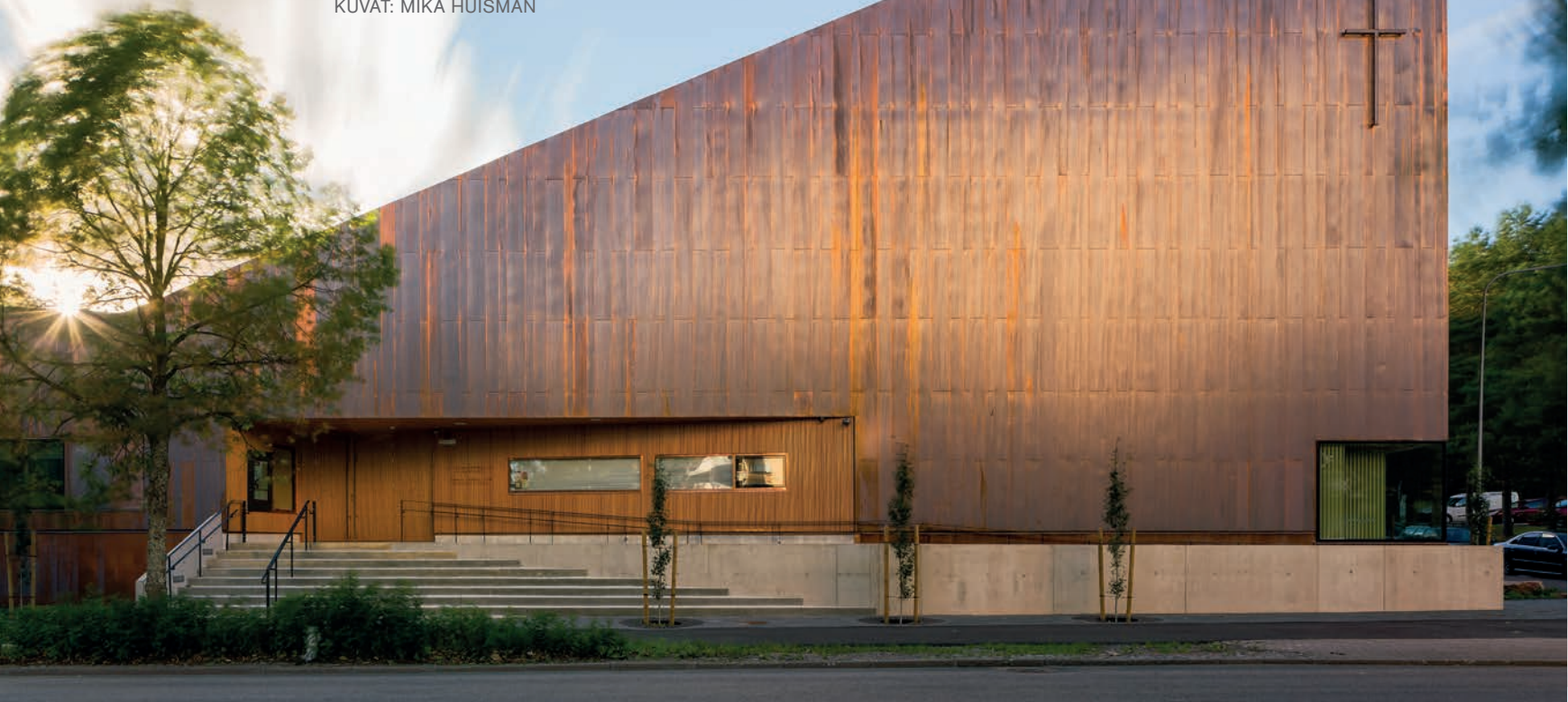
Suvelan kappelin kuparipeltipintainen julkisivu.
