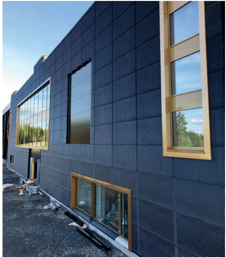
Julkisivun värit kuvastavat stadionilla pelaavan kotijoukkueen omia värejä.
