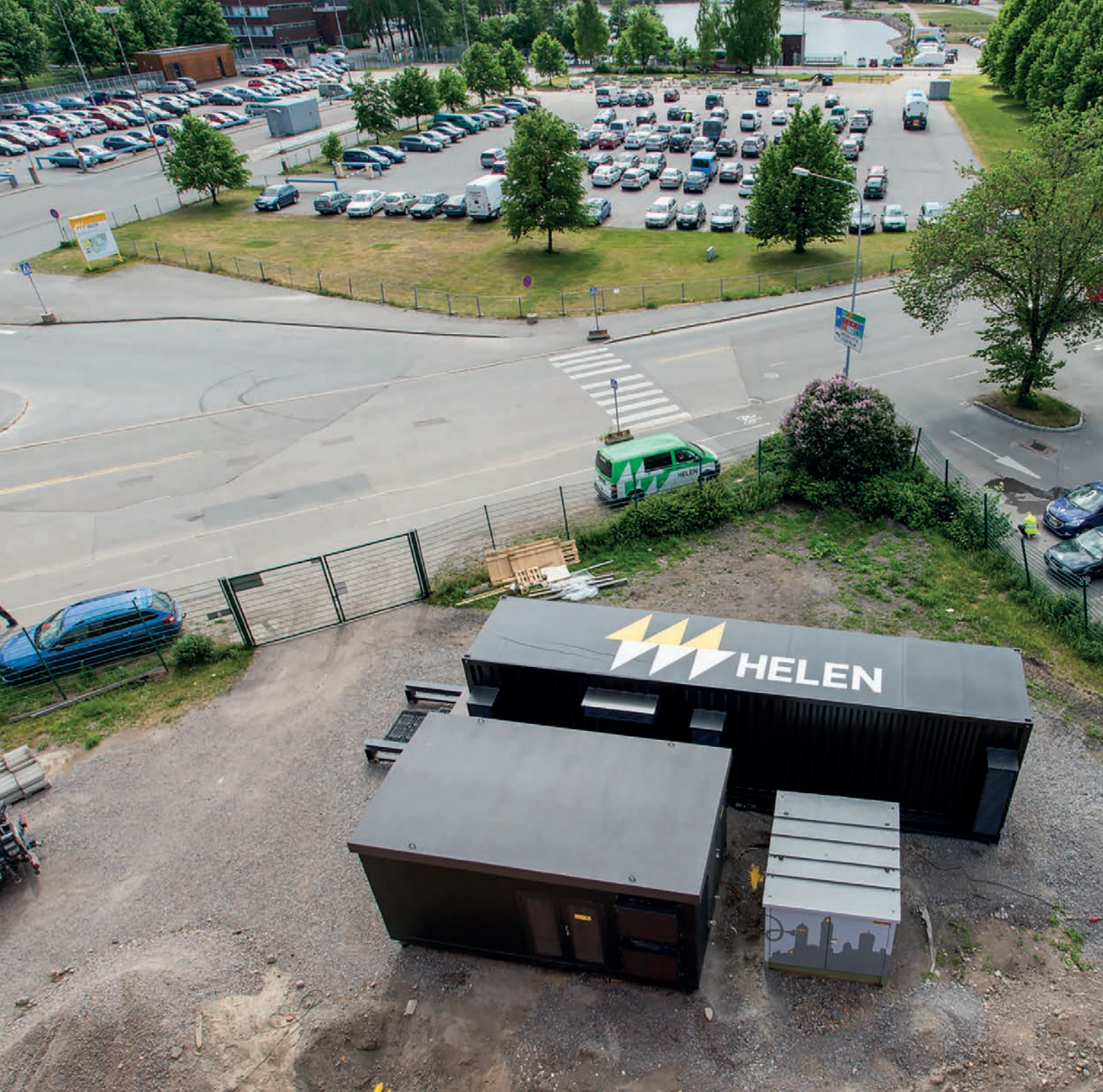
Helen otti elokuun alussa 2016 käyttöön Helsingin Suvilahdessa sijaitsevan suuren sähkövaraston.
